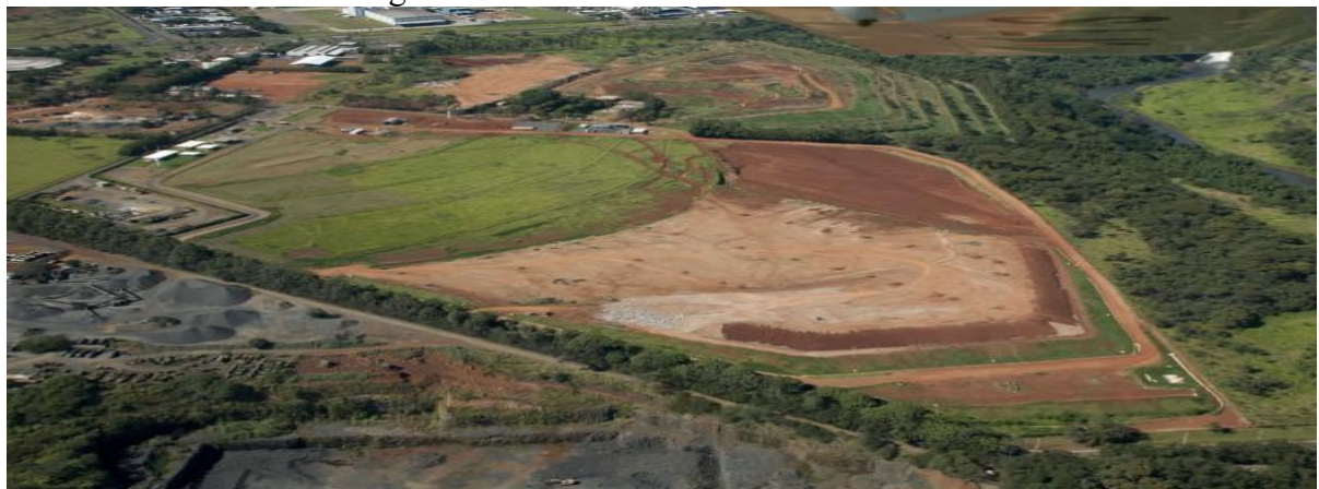
Figura 4 – Aterro Sanitário de Uberlândia.
