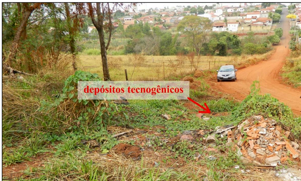
Figura 121. Área instável localizada nas proximidades do ponto 2, depósito tecnogênico
