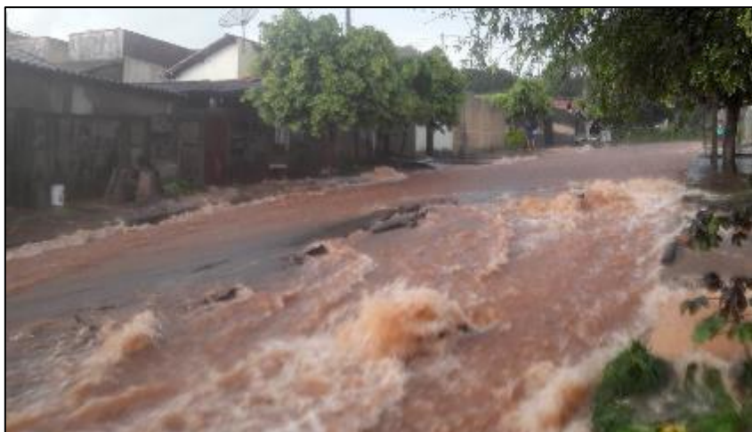
Figura 106. Enxurrada superficial decorrente da impermeabilização do solo (Rua Nossa Sra. Aparecida)
