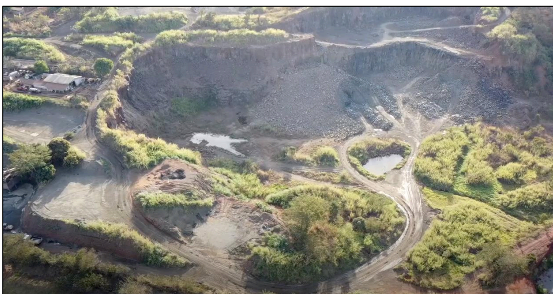
Figura 116. Área instável localizada nas proximidades do ponto 1, local de extração de basaltos
