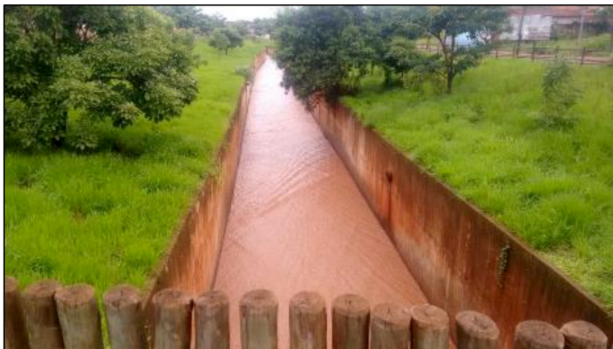
Figura 79. Ituiutaba-MG. Canalização aberta, Av: José João Dib
