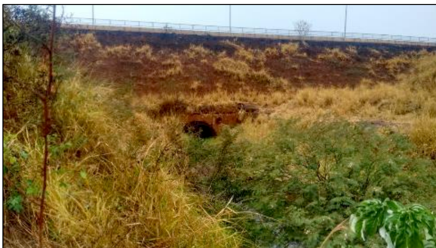
Figura 80. Ituiutaba-MG. Trecho do córrego Pirapitinga
