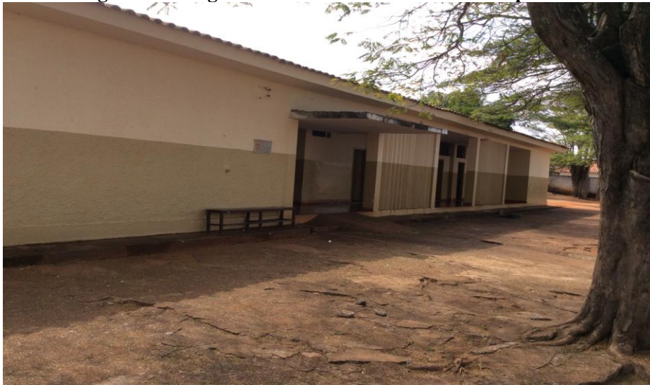
Figura 3- Fotografia do Pavilhão 1 da Escola Pesquisada
