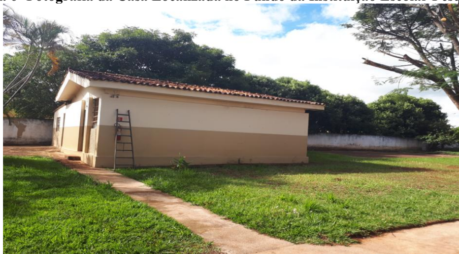
Figura 6- Fotografia da Casa Localizada no Fundo da Instituição Escolar Pesquisada
