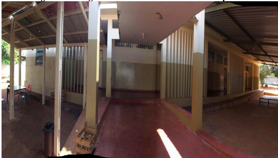
Figura 4- Fotografia do Pavilhão 2 da Escola Pesquisada
