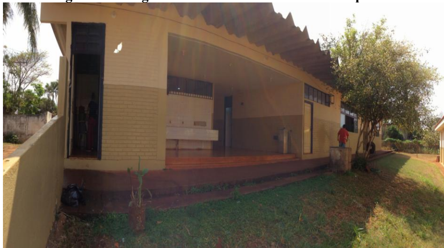
Figura 5- Fotografia do Pavilhão 3 da Escola Pesquisada
