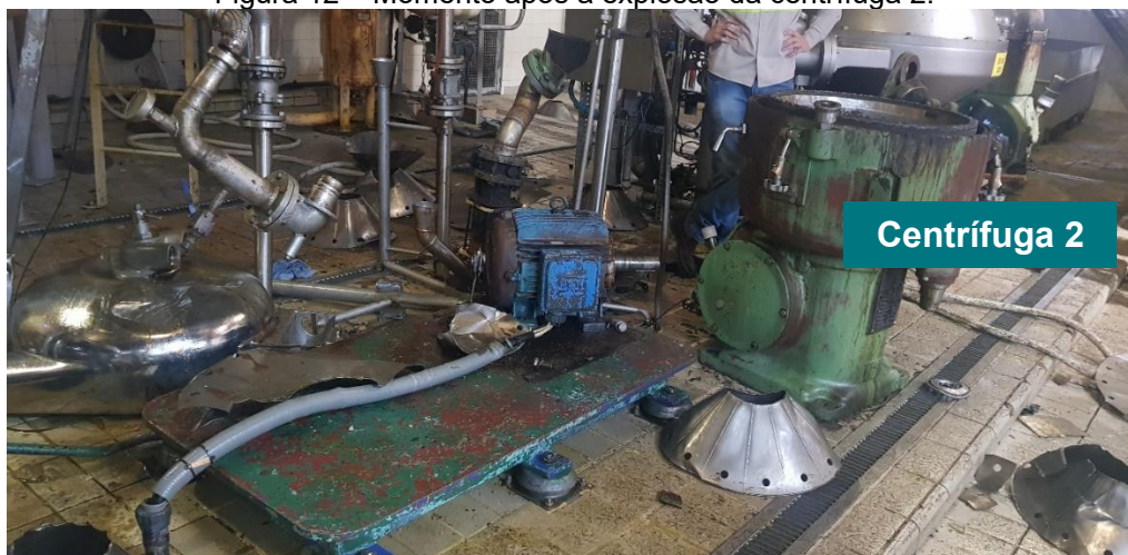
Figura 12 – Momento após a explosão da centrífuga 2.
