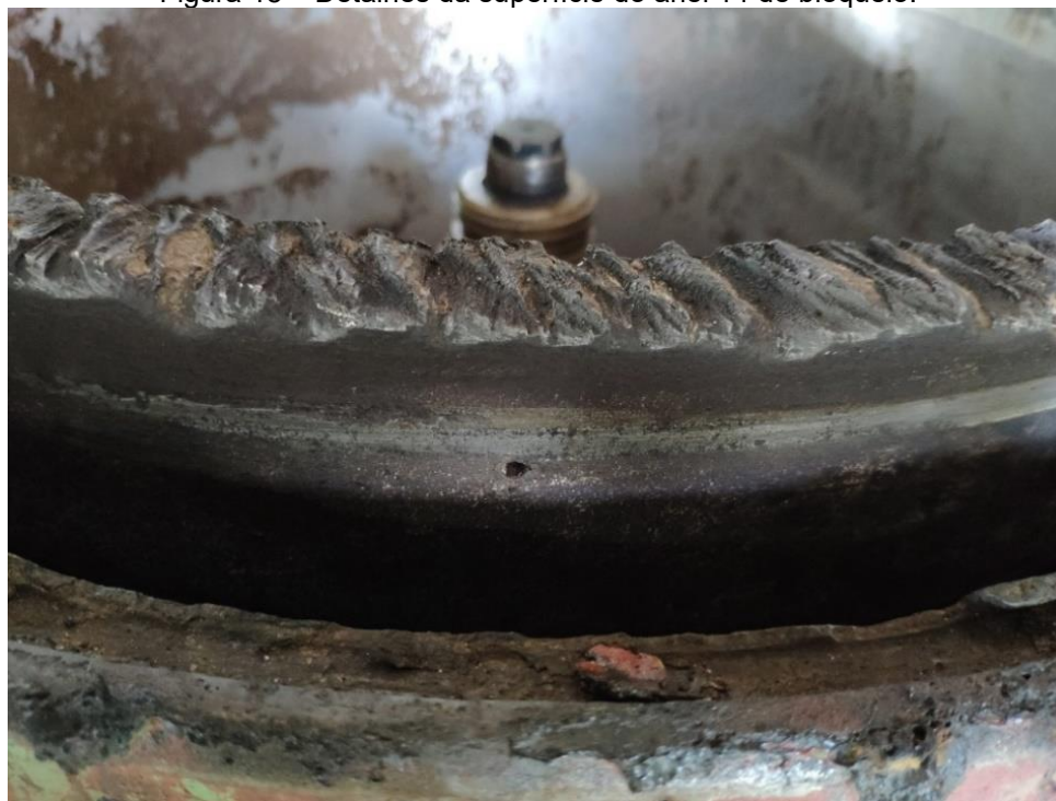
Figura 18 – Detalhes da superfície do anel 14 de bloqueio.
