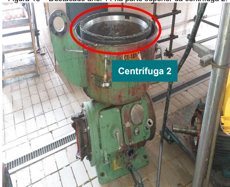
Figura 16 – Destacado anel 14 na parte superior da centrífuga 2.
