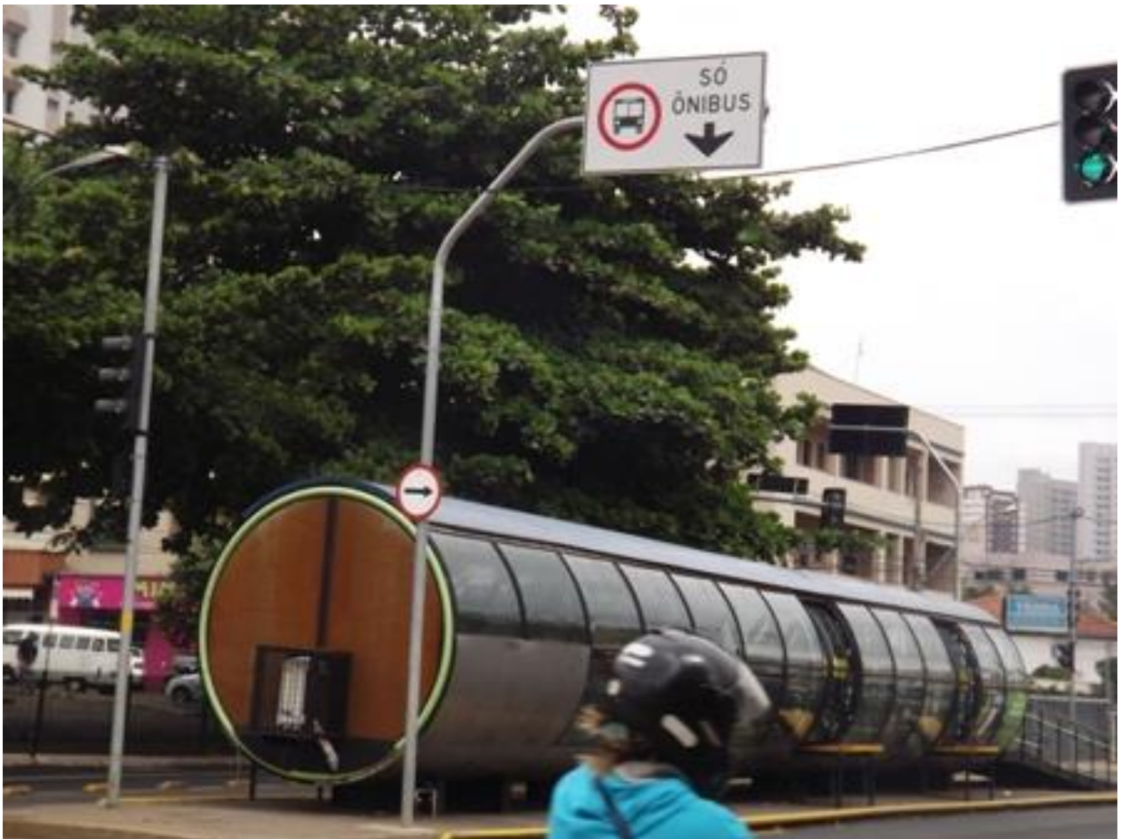
Figura 51: Estação BRT de Uberaba
