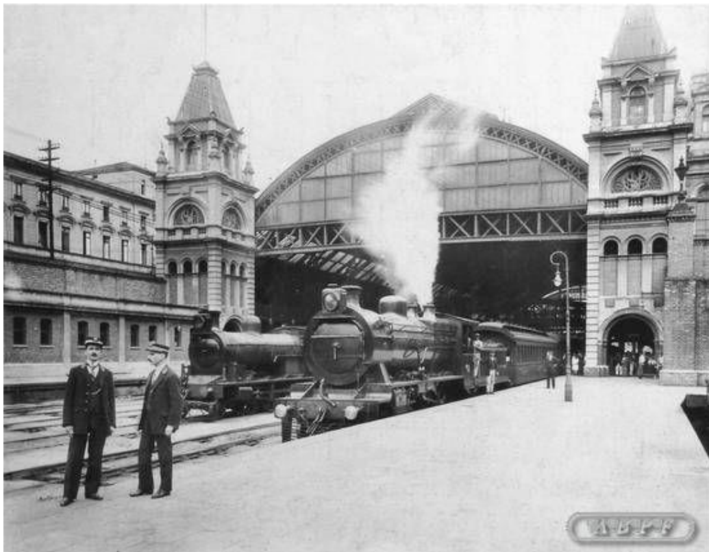
Figura 2: Estação da Luz, São Paulo -1920
