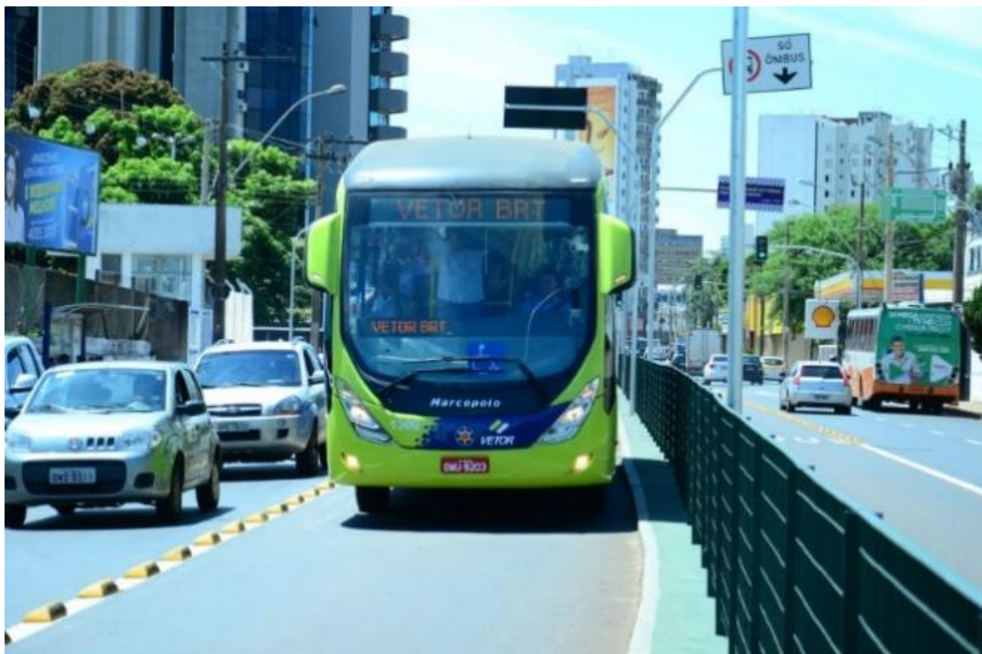
Figura 22 Implantação do sistema BRT na Av. Leopoldino de Oliveira
