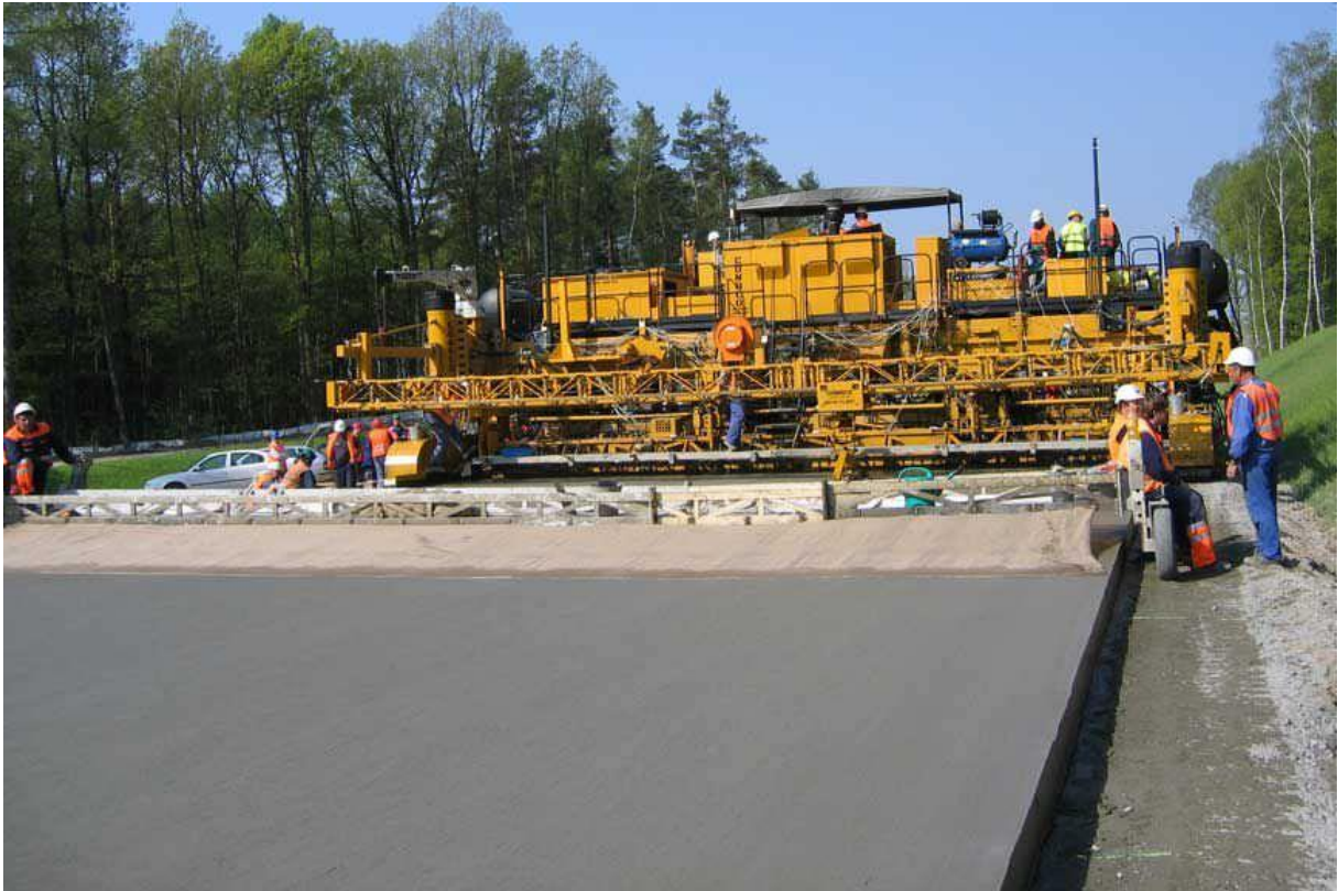
Figura 67: Pavimento rígido em execução
