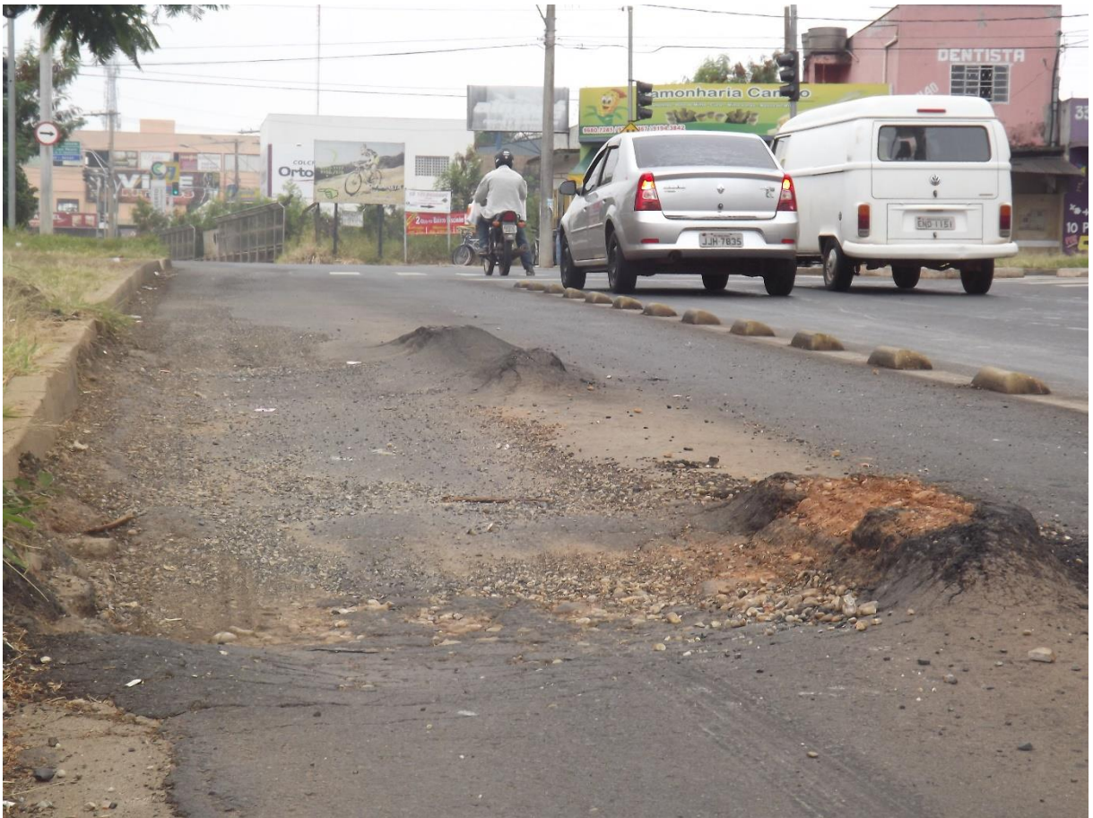
Figura 62: Pavimentação corredor BRT AV. Leopoldino de Uberaba.
