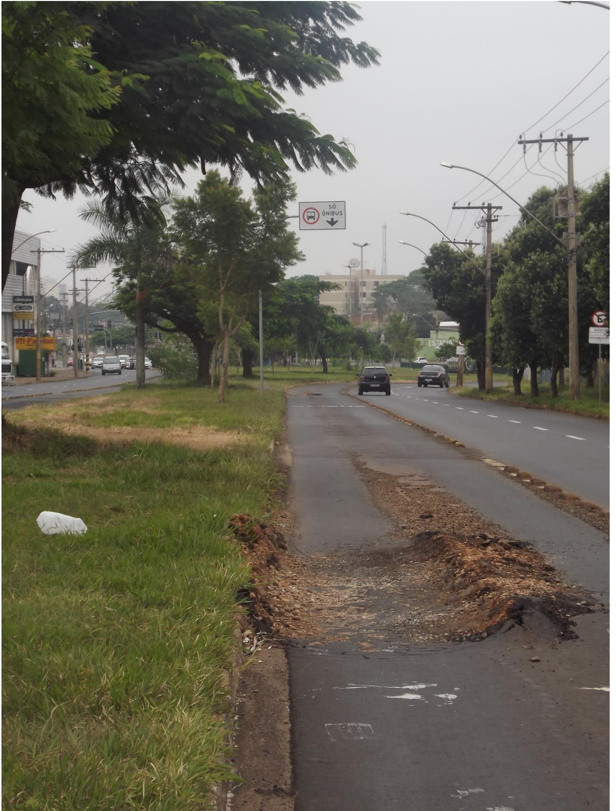
Figura 65: Pavimentação corredor BRT AV. Leopoldino de Uberaba.
