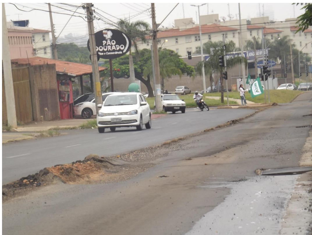
Figura 64: Pavimentação corredor BRT AV. Leopoldino de Uberaba.
