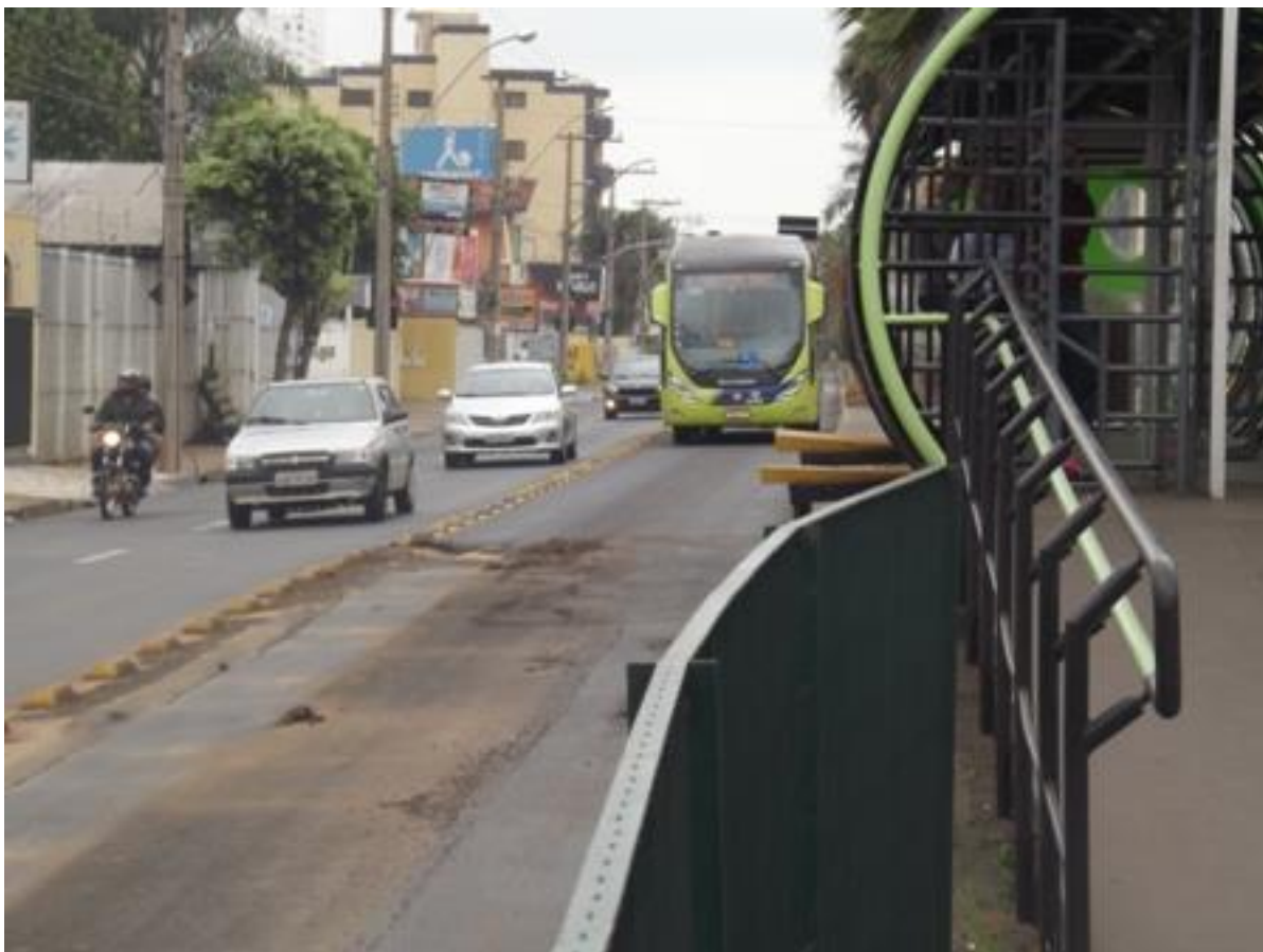
Figura 23: Av. Leopoldino de Oliveira após instalação do BRT
