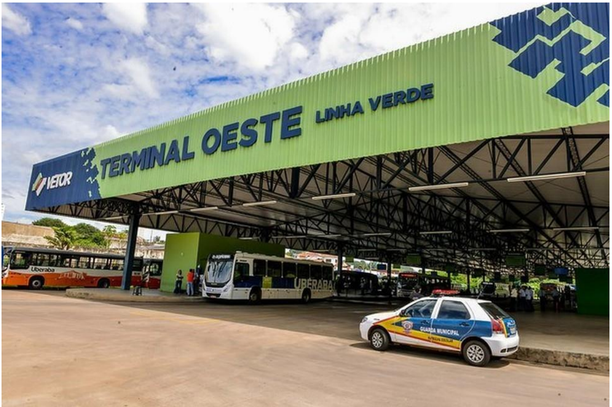
Figura 38: Terminal Oeste BRT- Uberaba-MG Fonte: G1.Globo/Prefeitura Municipal de Uberaba
