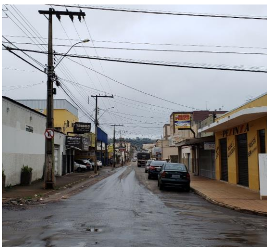
FIAÇÃO AÉREA CONVENCIONAL Figura 112 – Vista da R. Ponto Chic com fiação aérea convencional. Foto: autor, 2020.
