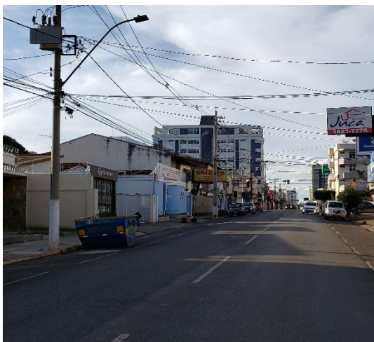
FIGAÇÃO AÉREA COMPACTA/ BLINDADA Figura 118 – Trecho da R. Dr. Marcolino com fiação aérea compacta. Foto: autor, 2020.
