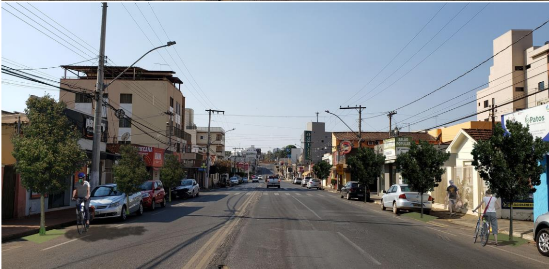
Figura 92 - Rua Major Gote (T1) sem árvores e simulação com árvores de pequeno porte. Foto: autor, 2019. Montagem elaborada por: autor; Silva, N.R., 2020.
