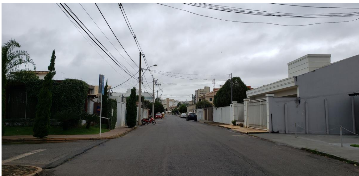
Figura 84 – Exemplo de via com fiação aérea compacta/ blindada, localizada na R. Rio Grande. Foto: autor, 2020.
