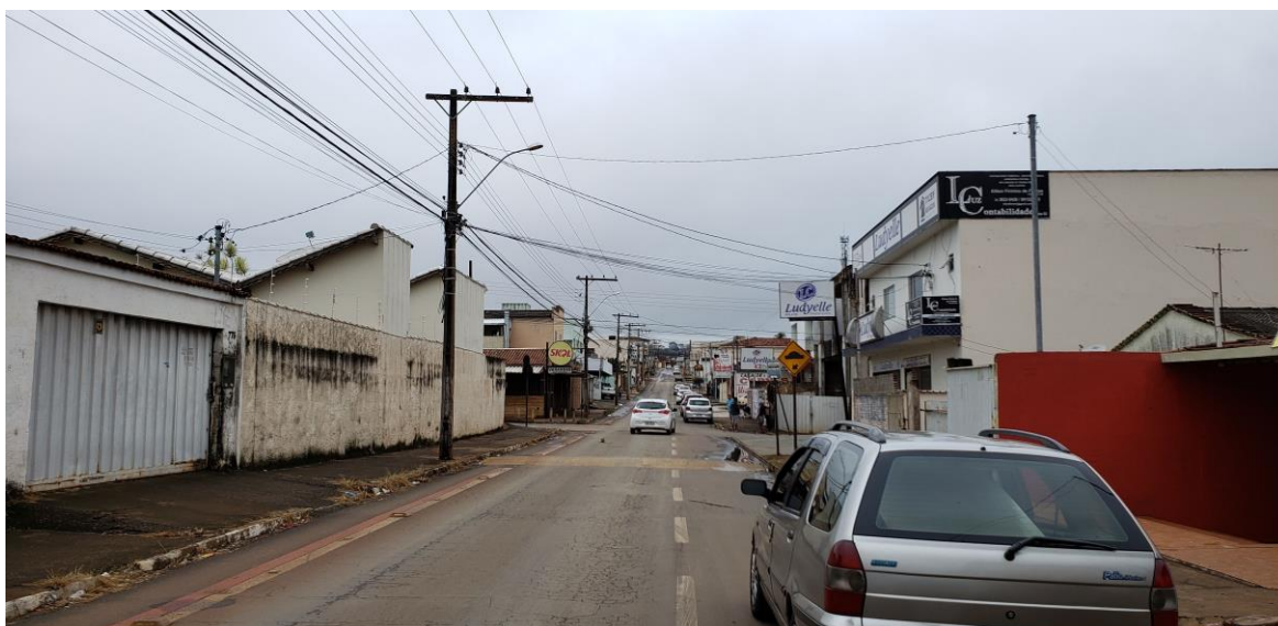
Figura 83 – Exemplo de via com fiação aérea convencional, localizada na R. Ponto Chic. Foto: autor, 2020.
