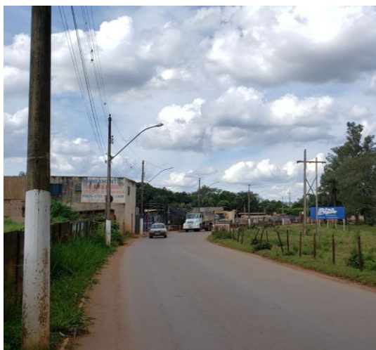
FIÇÃO AÉREA COMUM Figura 100 – Trecho da Av. Joaquim Fubá com fiação aérea comum. Foto: autor, 2019.
