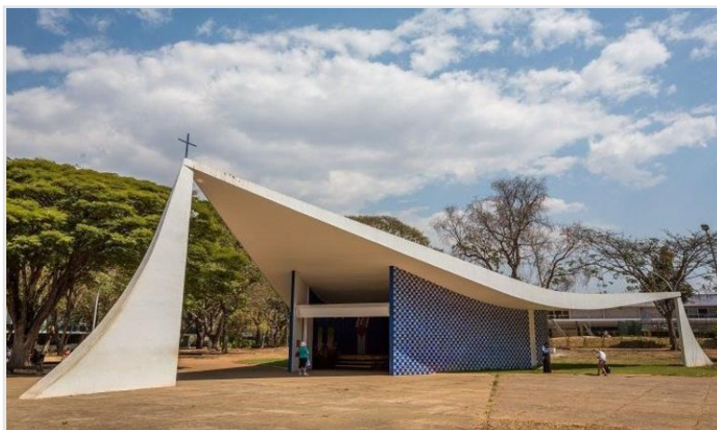
[16] Igrejinha de Fátima (1958) - vista lateral. Fonte: Archdaily (2014). Disponível em: https://www.archdaily.com.br/br/601545/classicos-da-arquitetura-igrejinha-nossa-senhora-de-fatima-slash-oscar-niemeyer/5369f33ec07a80292e00017c-classicos-da-arquitetura-igrejinha-nossa-senhora-de-fatima-slash-oscar-niemeyer-imagem . Acesso em 17 de julho de 2020.
