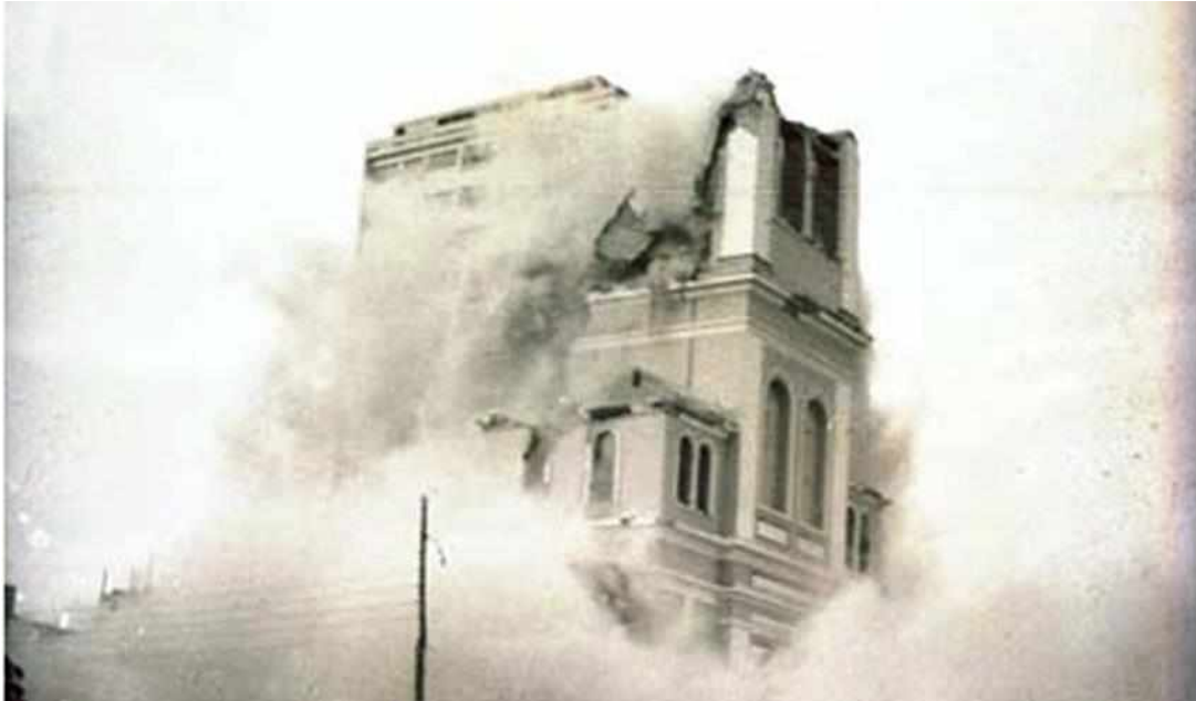
Figura 8 – Demolição da catedral de São José do Rio Preto, 1974
