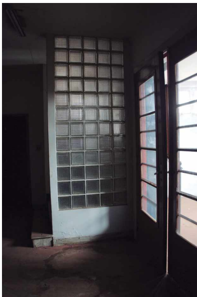
G30 Acesso a área externa
