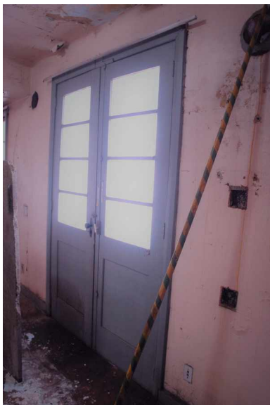
P3 Porta de acesso ao corredor de circulação externo
