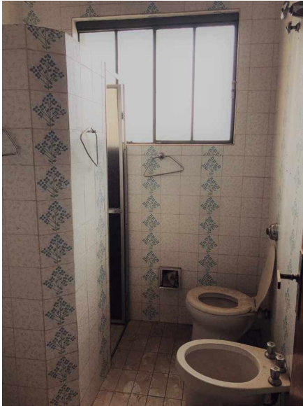
G34 Banheiro Apto° 06
