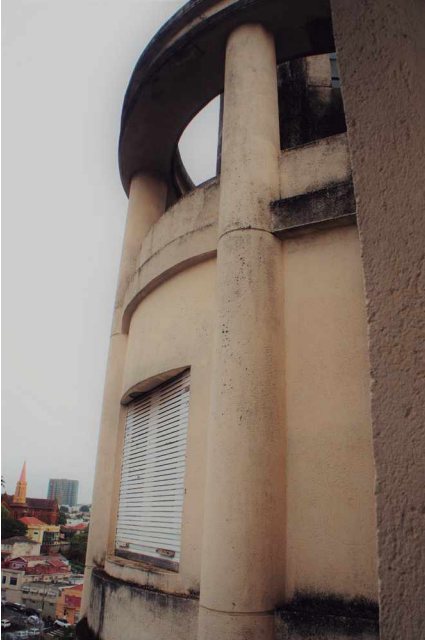
G50 Vista externa do último andar
