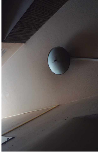
I11 Iluminação da circulação
