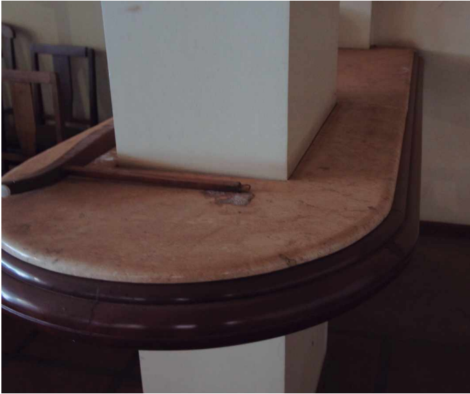
D10 Detalhe do Hall de Entrada
