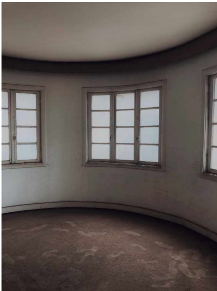
G40 Circulação externa do restaurante
