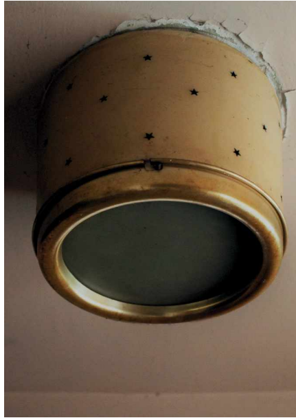
I4 Detalhe da luminária do cinema
