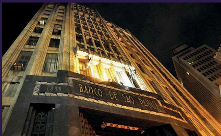
Figura 21 O edifício do Banco São Paulo, com características Art Déco. Fonte: https://spcity.com.br/art-deco-a-riqueza-de-detalle1-em-um-edificio-historico-no-centro-de-sao-paulo/
