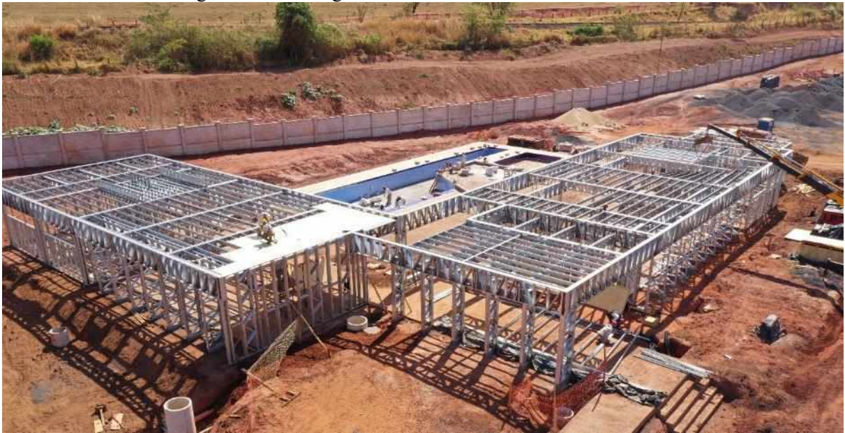
Figura 10 – Visão geral da estrutura LSF referente ao clube
