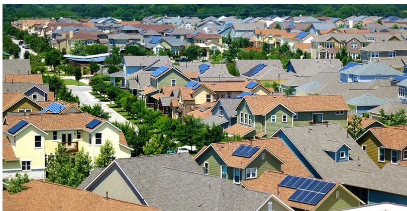
Figura 5 - Geração distribuída (Sistema Fotovoltaico) (MECATRONSOLA, 2020)
