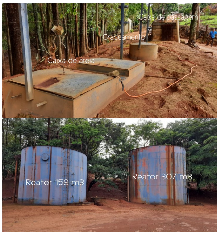
Figura 4 - Estação de tratamento de esgoto de Rio Paranaíba - MG.
