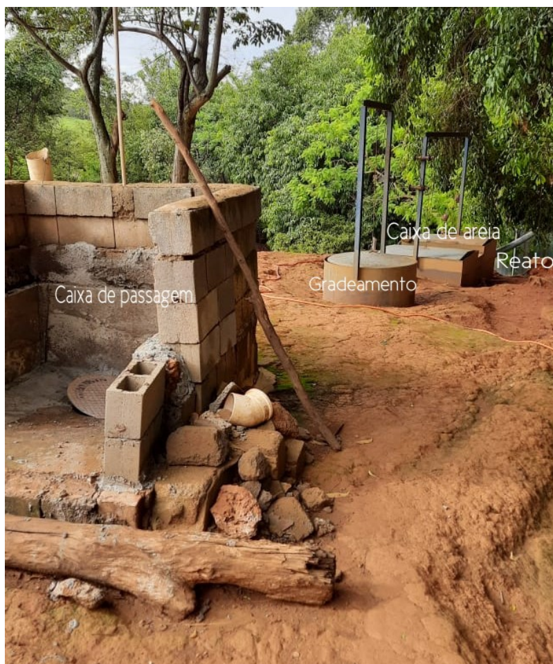
Figura 5 - Estação de tratamento de esgoto de Rio Paranaíba - MG.
