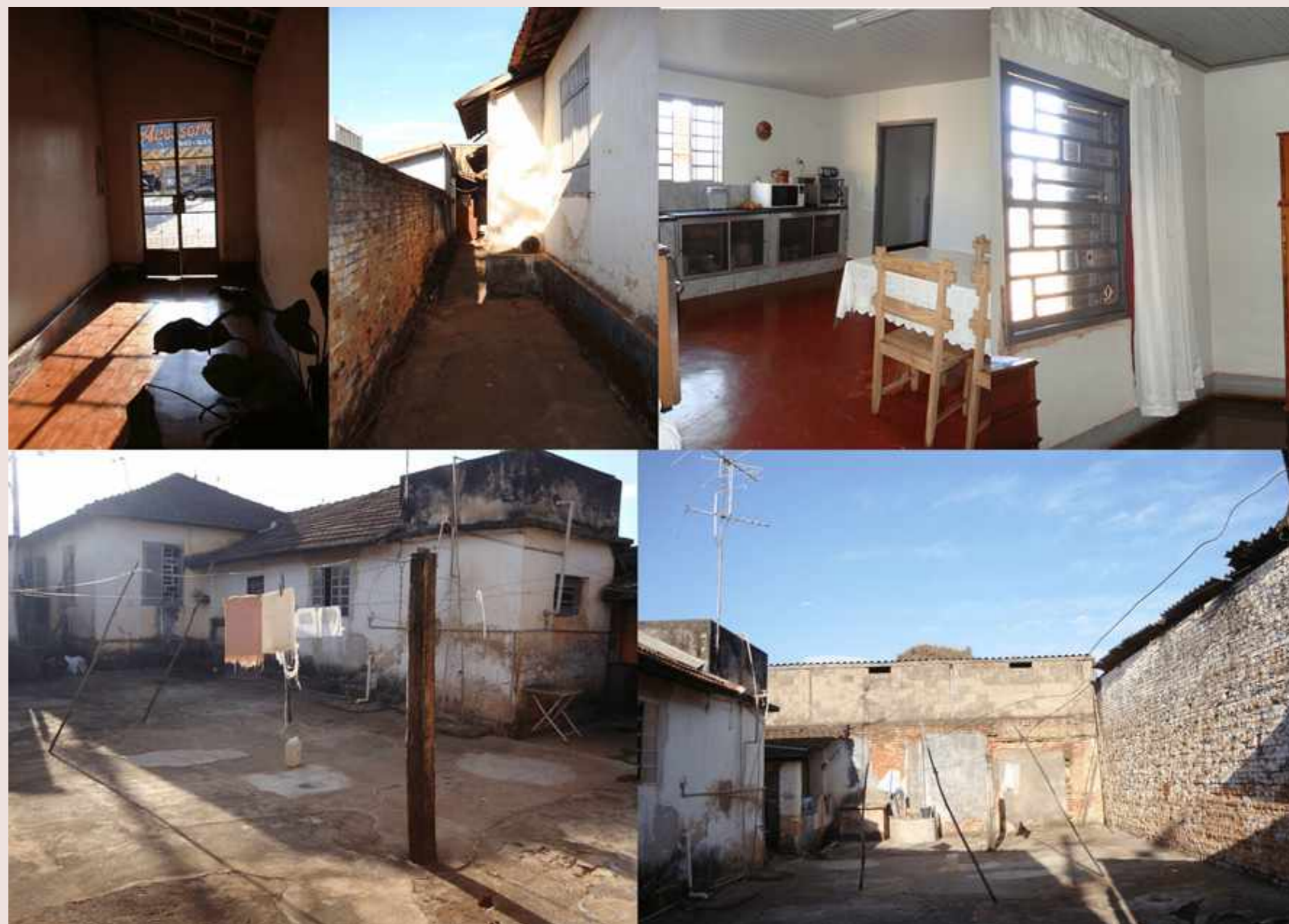
Figura 54: Imagens do imóvel em 2011 – ocupado. Fonte: A Autora.
