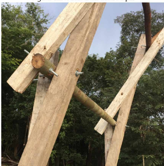
Figura 55: Detalhe da construção
