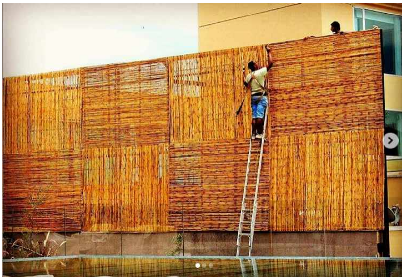
Figura 59: Fechamento em bambu
