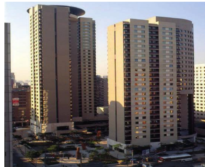
Figura 25: Torres dos edifícios Cooperativo e Hoteleiro.
