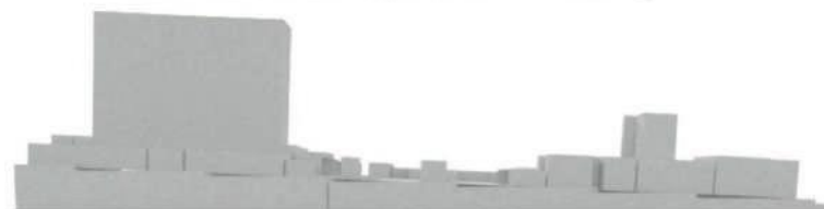
Fachada Nordeste (Rua Santos Dumont):
