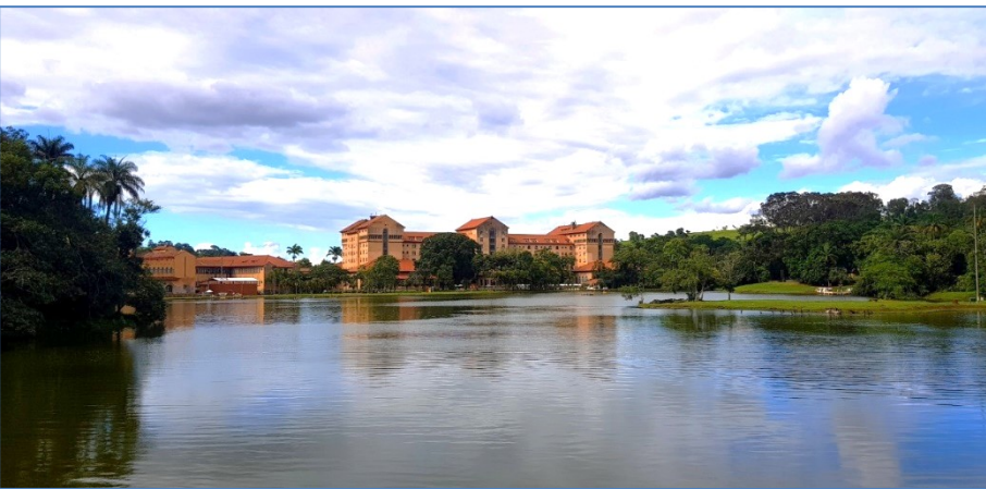
Vista do prédio do Grande Hotel de Araxá.
