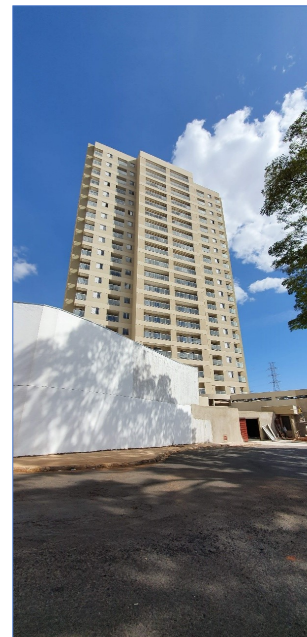
Figura 197 – Araxá: condomínio vertical em construção no setor centro-sul. Fonte: Souza (2020).
