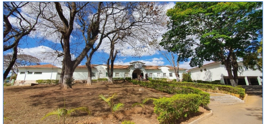
Figura 237 – Santa Casa de Ibiá. Fonte: Souza (2020).
