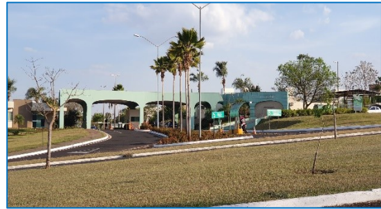
Figura 32 – Entrada de um condomínio fechado na zona sul de Uberlândia (Brasil). Fonte Souza (2019).
