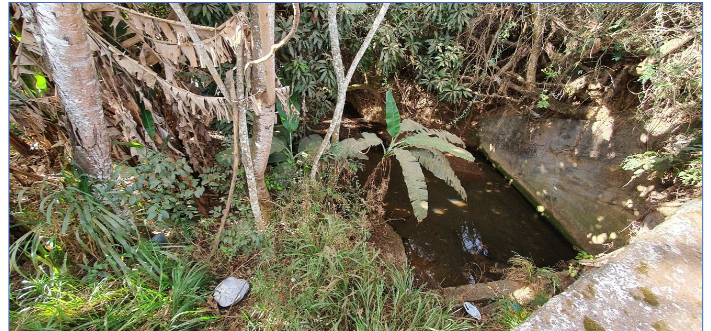
Figura 150 – Ibiá: córrego com presença de esgoto a céu aberto. Fonte: Souza (2020).
