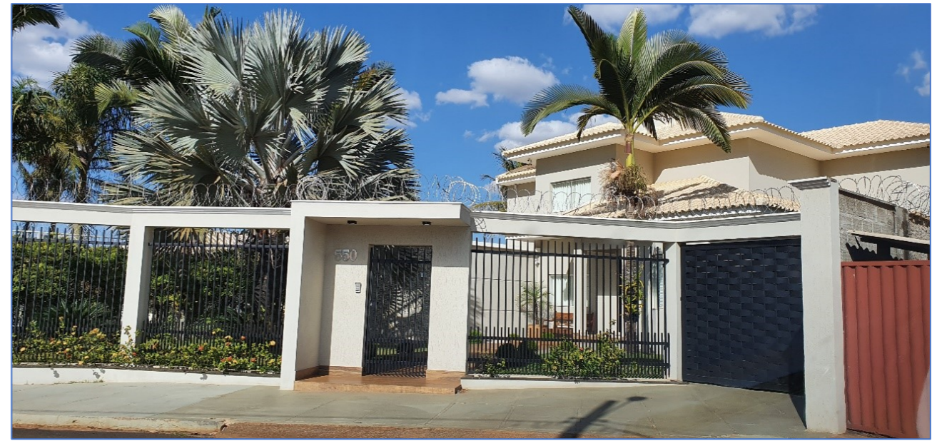
Figura 187 – Pedrinópolis: domicílio com alto padrão de construção em avenida na área central. Fonte: Souza (2020).
