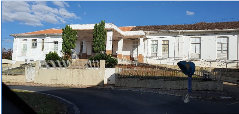
Figura 234 – Santa Casa de Araxá. Fonte: Souza (2020).
