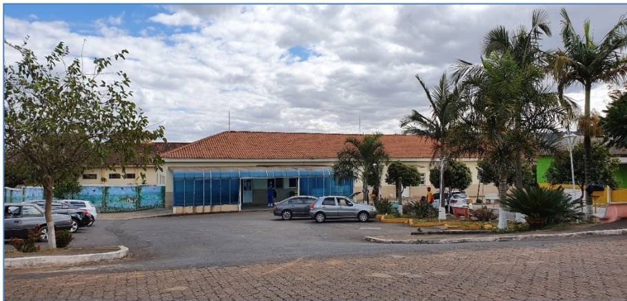
Figura 236 – Santa Casa de Campos Altos. Fonte: Souza (2020).
