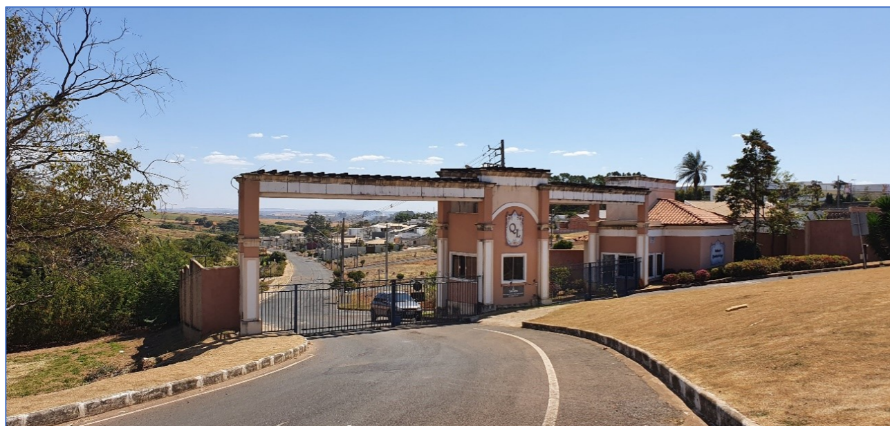
Figura 192 – Araxá: condomínio horizontal fechado no setor noroeste. Fonte: Souza (2020).
