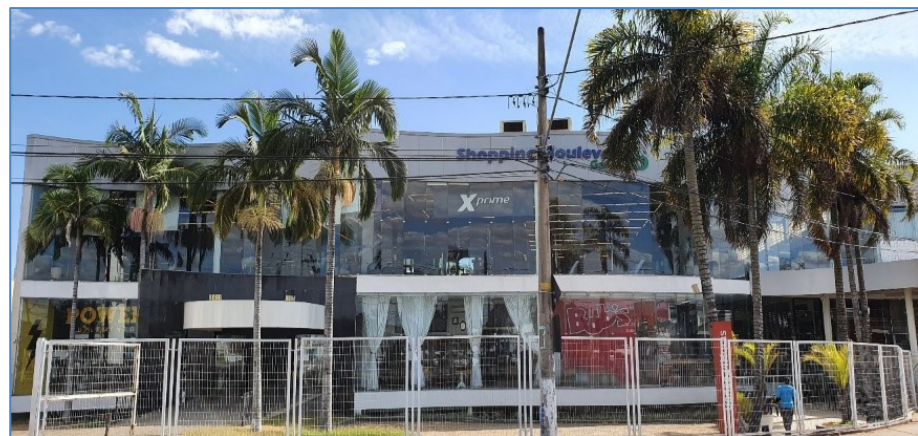
Figura 292 – Araxá: Boulevard Garden. Fonte: Souza (2020).
