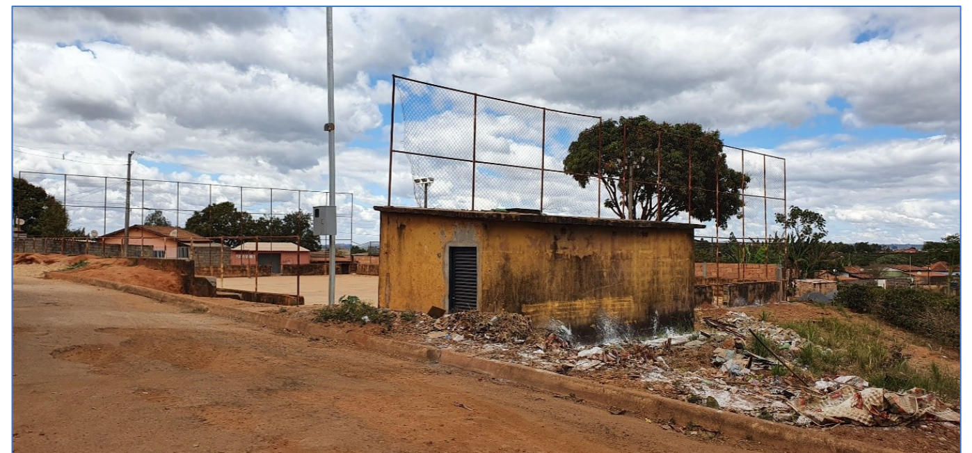
Figura 161 – Santa Rosa da Serra: lixo acumulado em praça pública. Fonte: Souza (2020).
