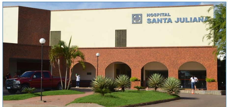
Figura 239 – Santa Casa de Santa Juliana. Fonte: Prefeitura Municipal de Santa Juliana (2020).
