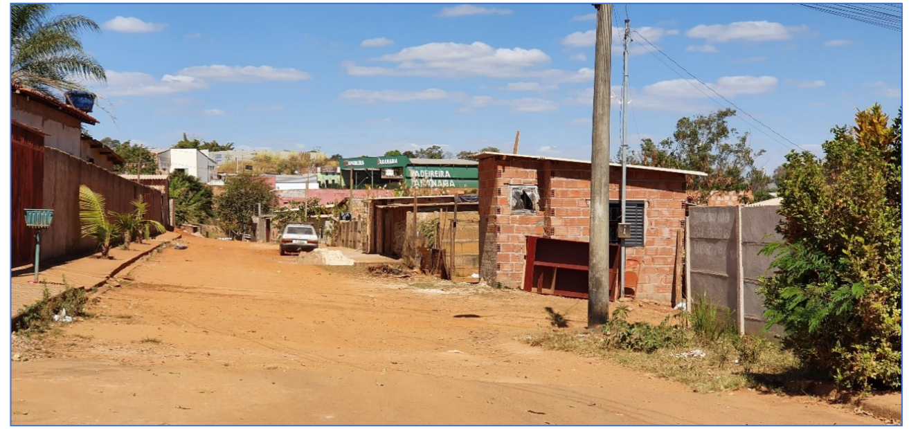
Figura 171 – Araxá: rua sem pavimentação no bairro Bom Jesus. Fonte: Souza (2020).
