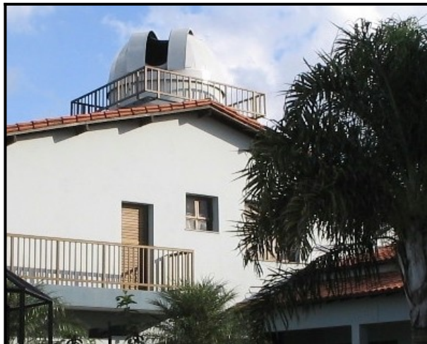
Figura 3 – Observatório astronômico construído na casa de Roberto Silvestre.
