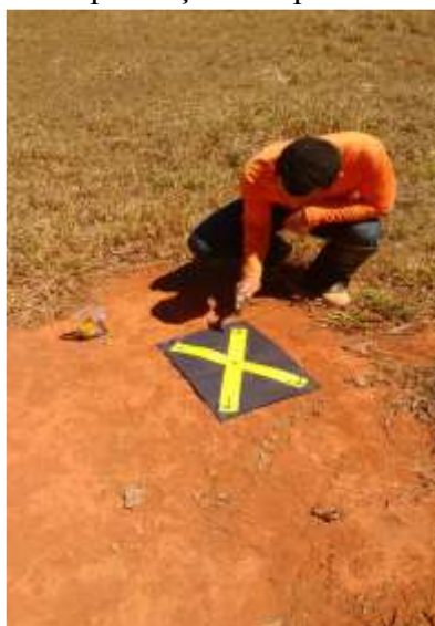
Figura 7 – Implantação dos pontos de controle.
