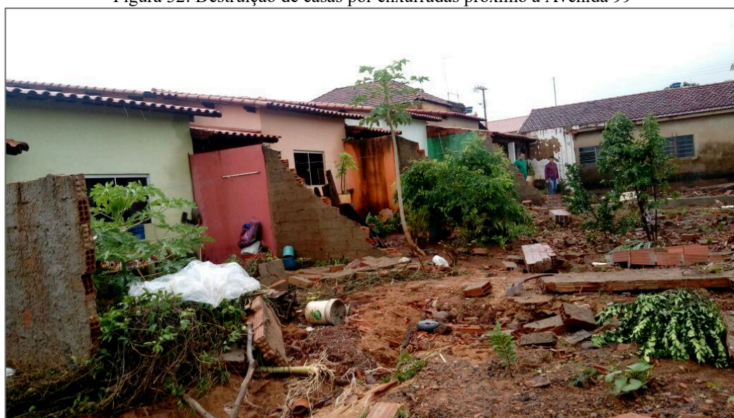
Figura 32: Destruição de casas por enxurradas próximo à Avenida 99
