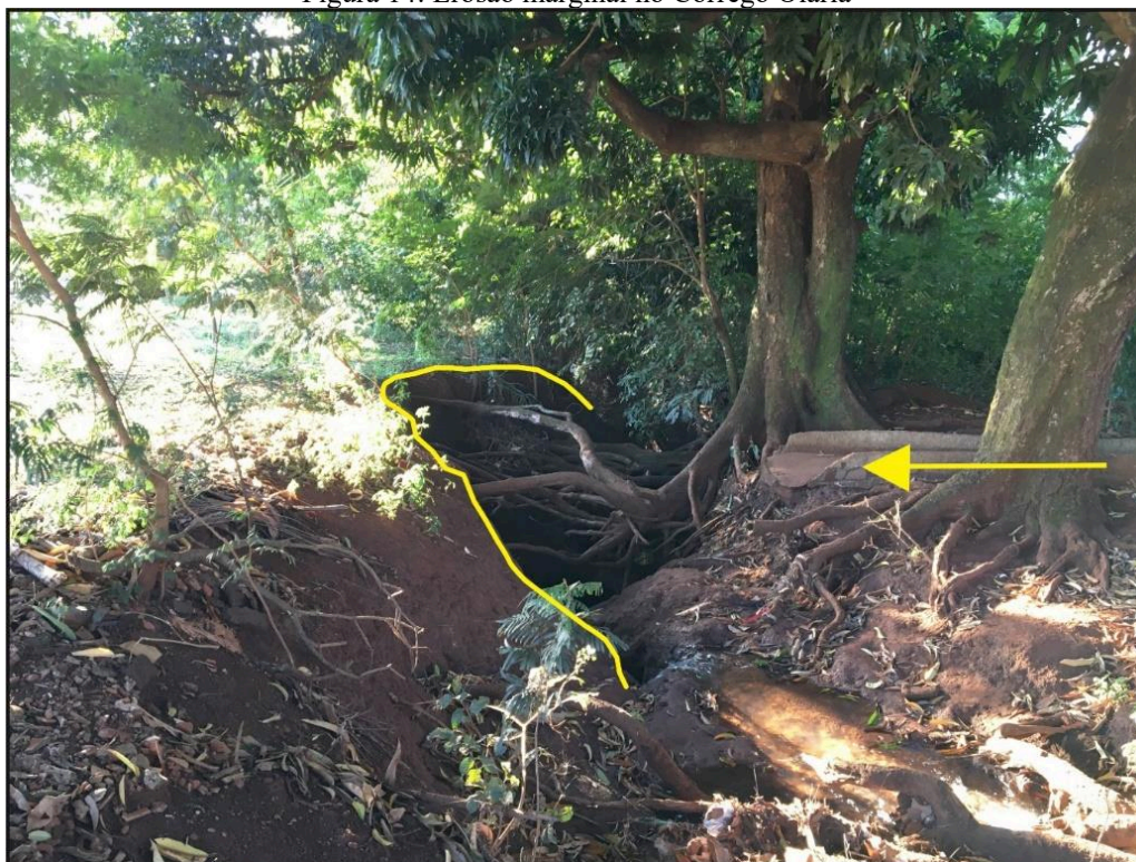
Figura 14: Erosão marginal no Córrego Olaria
