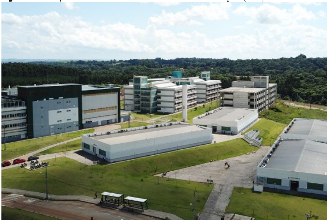
Figura 40: Instalações da Universidade Federal da Fronteira Sul em Chapecó (2019)
