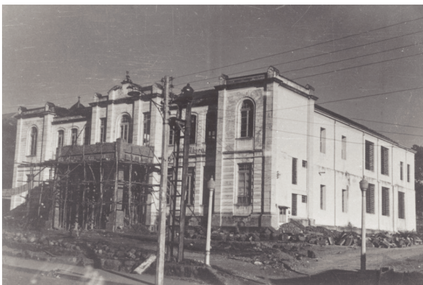
Figura 25. Obras de reforma do prédio da FMTM, [1960]
