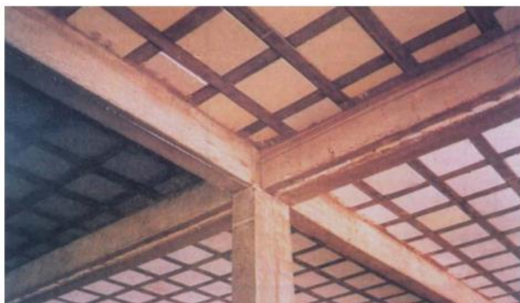
Figura 5 – Laje nervurada bidirecional com EPS
