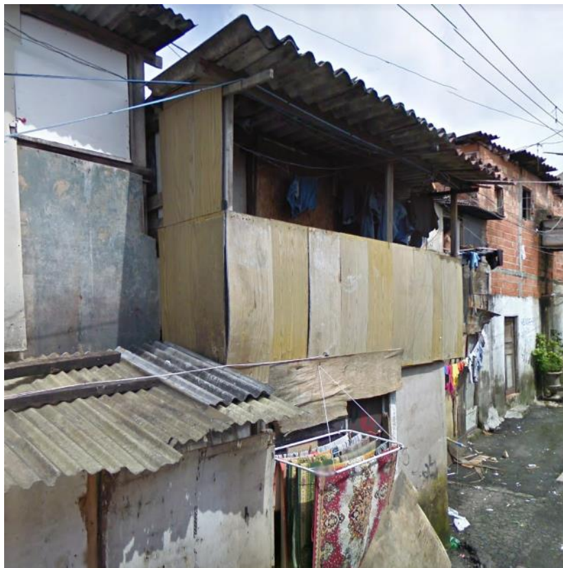
Figura 1.5 – Edificação a ser reaproveitada para a iniciativa proposta
