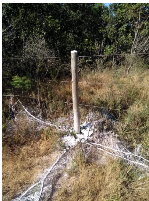
Figura 26 – Demarcação dos pontos de controle com cal hidratada
