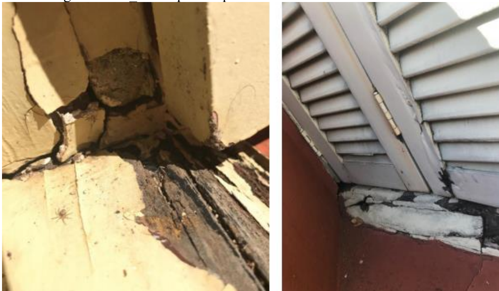
Figura 38: J1_2 com partes apodrecidas no batente e nas venezianas
