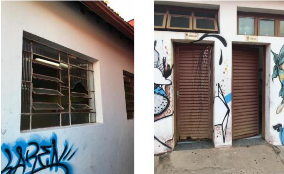
Figura 46: Esquadrias do Bloco D
