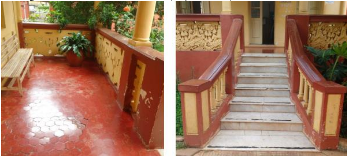
Figura 49: Piso em cerâmica e em mármore, respectivamente, na área externa do Bloco B
