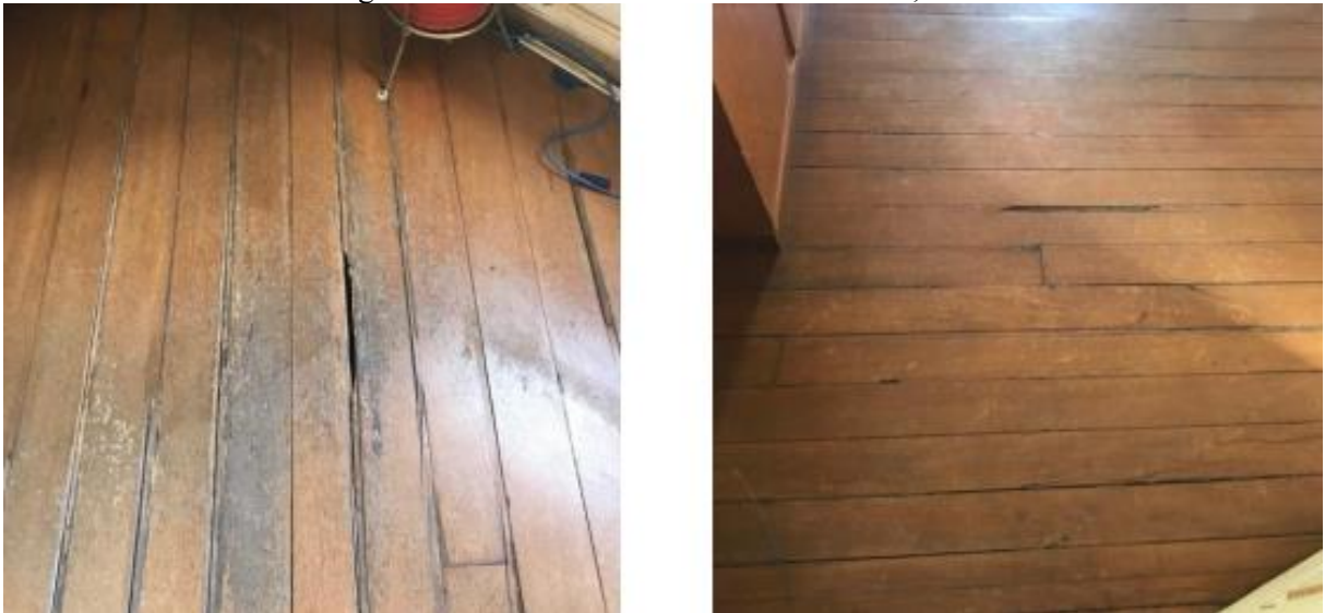
Figura 48: Piso de madeira da sala de área 20,13 m 2
