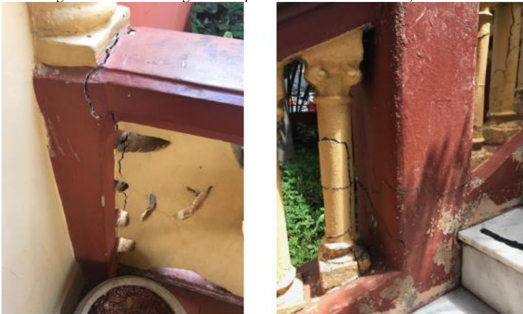
Figura 33: Estrutura do guarda-corpo e do corrimão da varanda, no Bloco B
