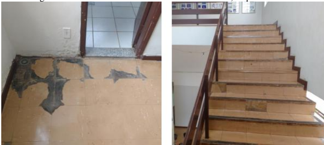
Figura 47: Piso vinílico do hall de entrada e da escada, respectivamente
