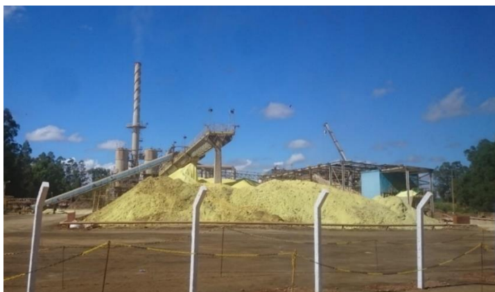
Figura 20: Planta de ácido sulfúrico da Mosaic no Complexo Mineroquímico de Araxá.
