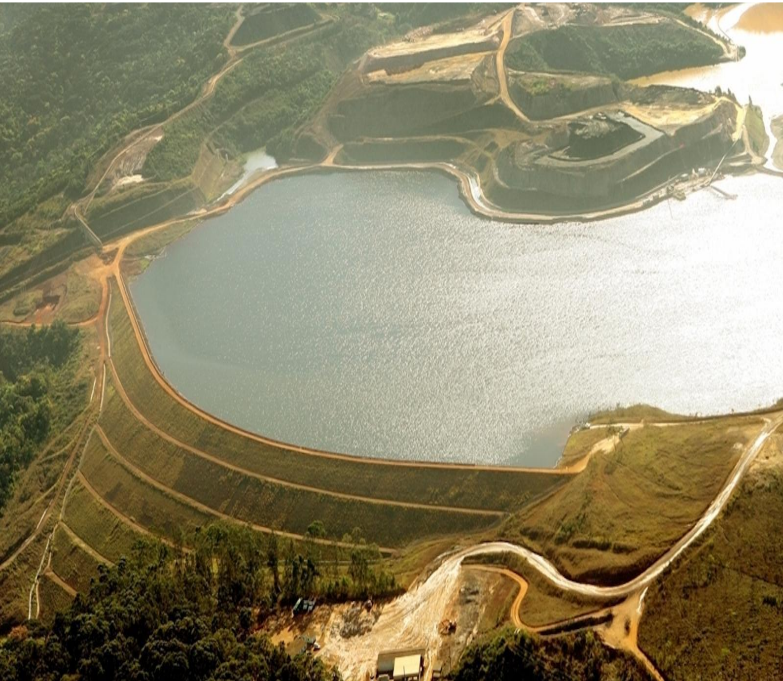
Legenda: Principal barragem de rejeito do Complexo Minerquímico de Tapira. Fonte: portalamirt.com.br
