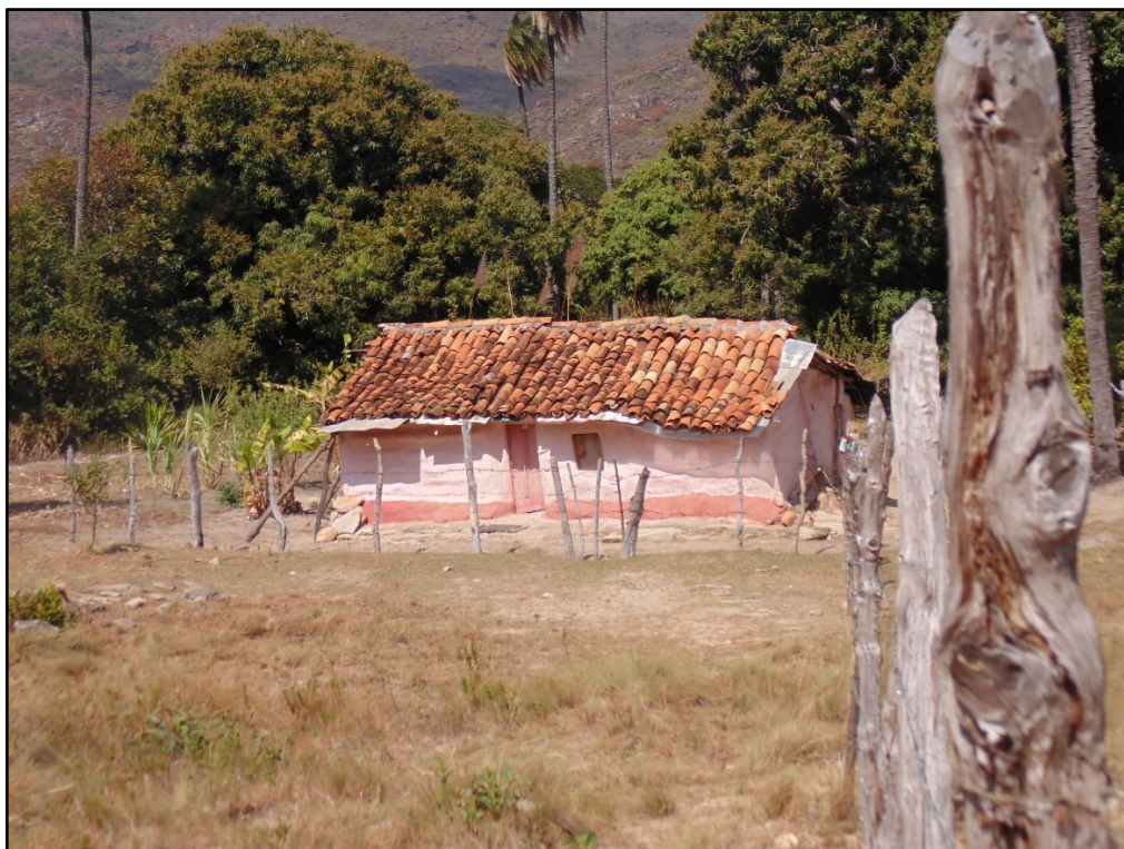
Foto 8: Casa localizada no interior do PARNA Serra do Cipó/Retiro – Casa centenária Autora: MOURA, I.B.R.; 2017
