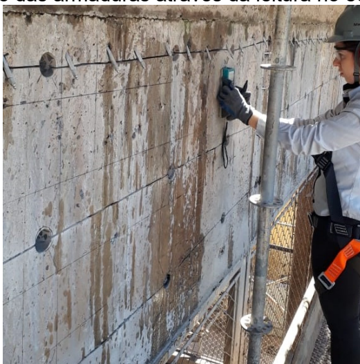
Figura 27 - Localização das armaduras através da leitura no equipamento Profoscope
