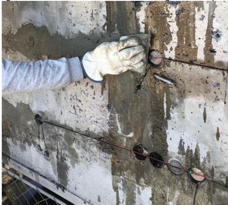
Figura 33 - Acabamento do sistema com argamassa especial
