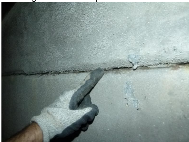
Figura 15 – Vista aproximada do sulco
