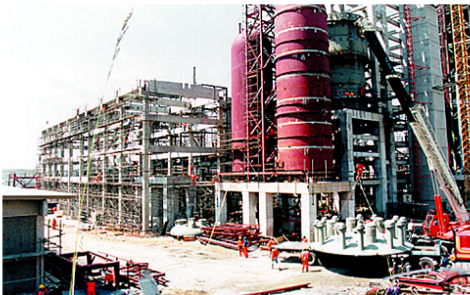
Figura 1.1: Construção de unidade composta pelo PAC-RC na refinaria Capuava, Mauá, São Paulo. www.ogj.com , acessado em 30 de maio de 2017.
