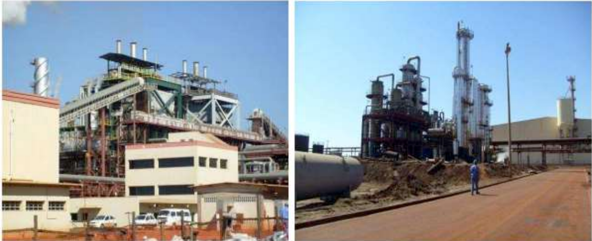
FOTO 1 – Instalações da Usina Sucroenergética em Quirinópolis (GO).
