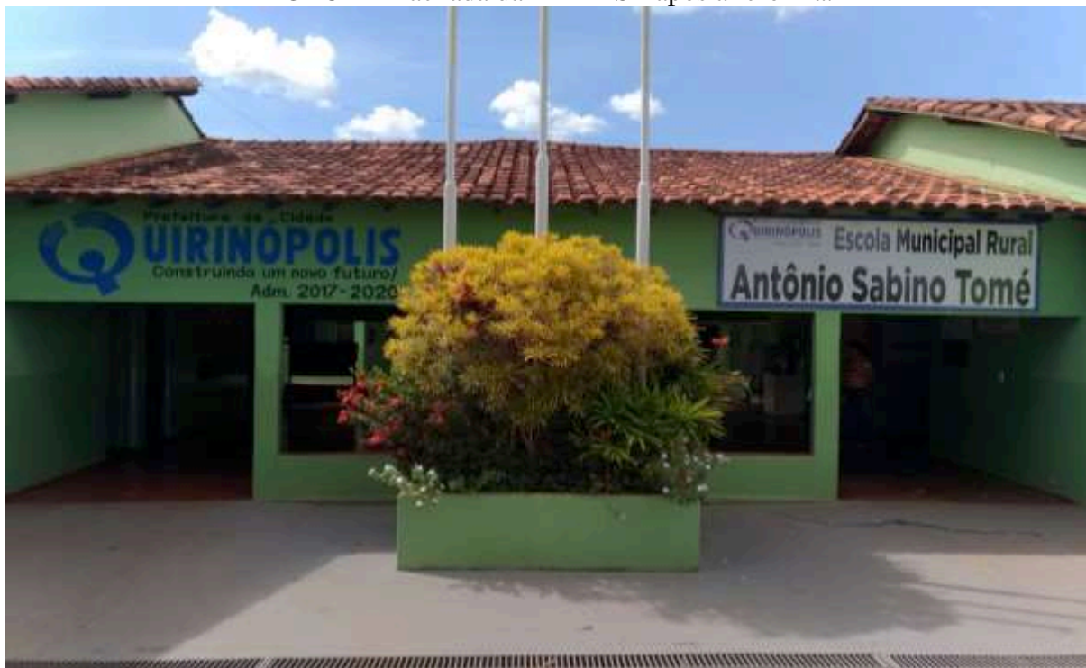
FOTO 4 – Fachada da EMRAST após a reforma.
