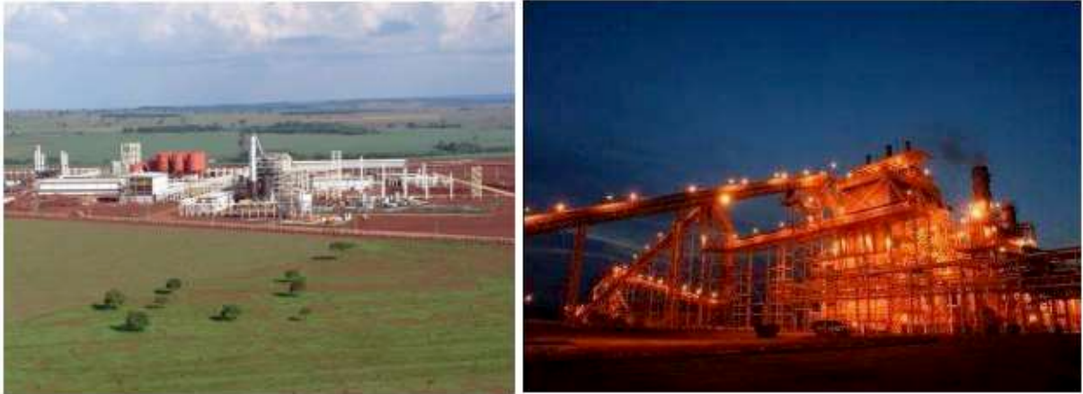
FOTO 2 – Instalações da Usina Sucroenergética em Quirinópolis (GO).
