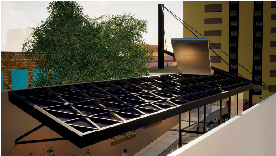
Figura 99: Vista da estrutura fluida e da estrutura com placas fotovoltaicas.
