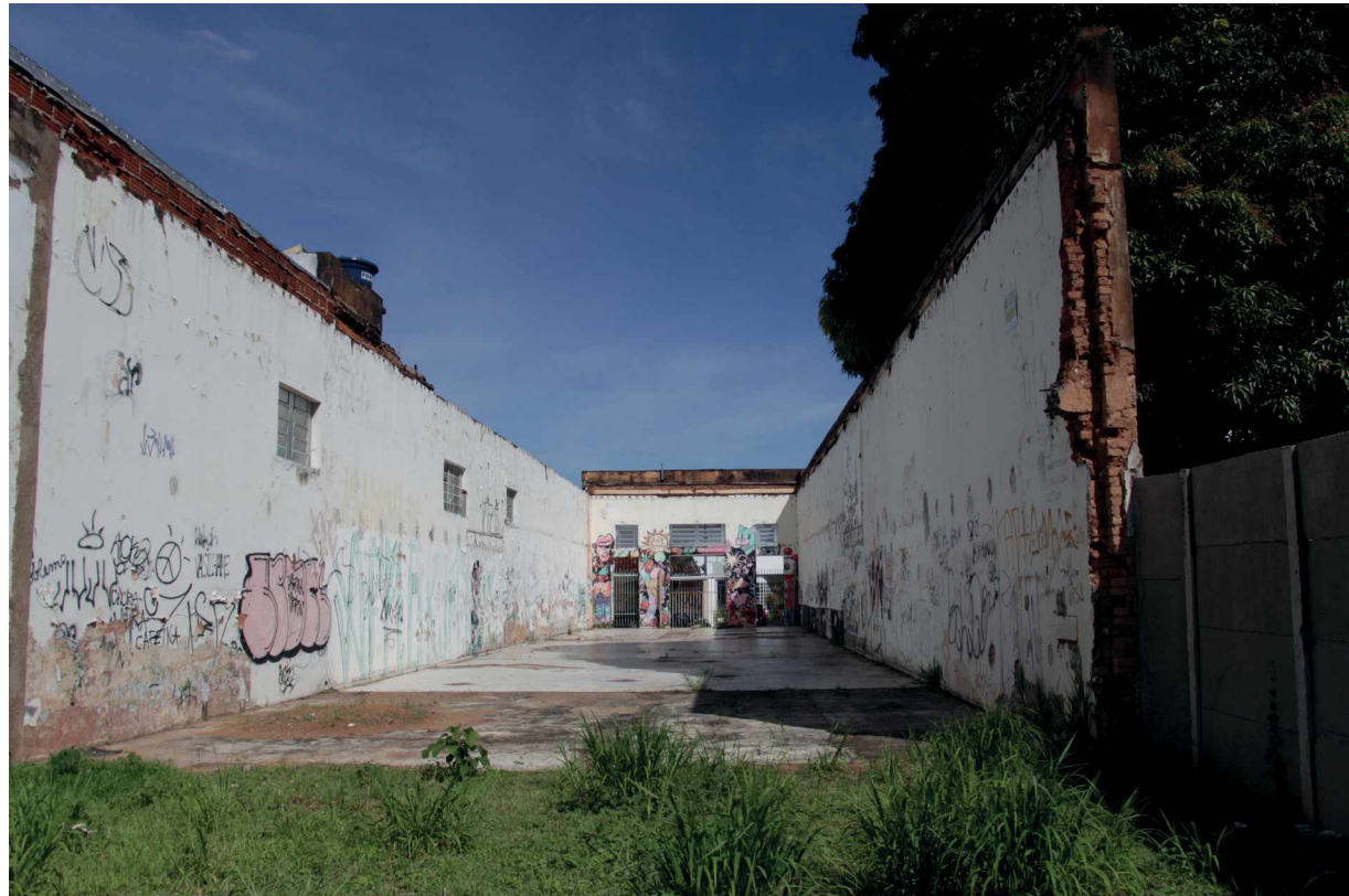
Figura 35: Vista do terreno, a partir da Rua Quinze de Novembro. Foto tirada pela autora em 19 de abril de 2019.
