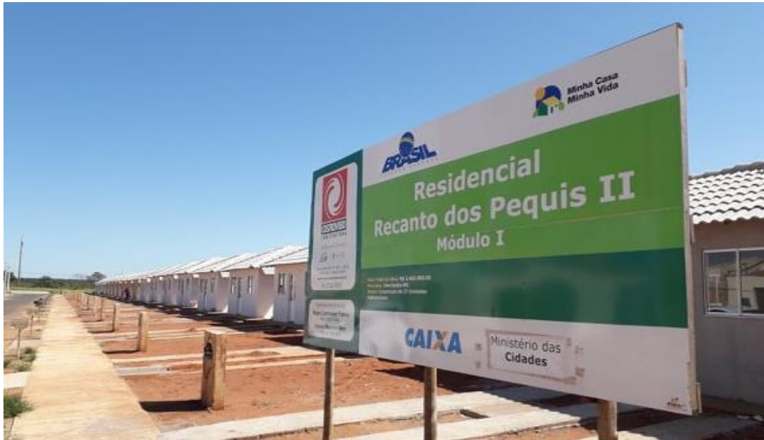
Foto 1: Uberlândia – MG. Casas destinadas à faixa 1 do PMCMV em fase final de construção no Residencial Pequis em 2018.
