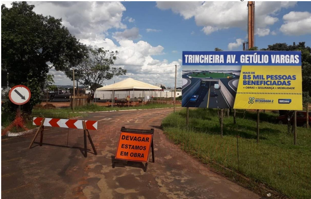
Foto 5: Uberlândia, MG – Obras na avenida Getúlio Vargas.
