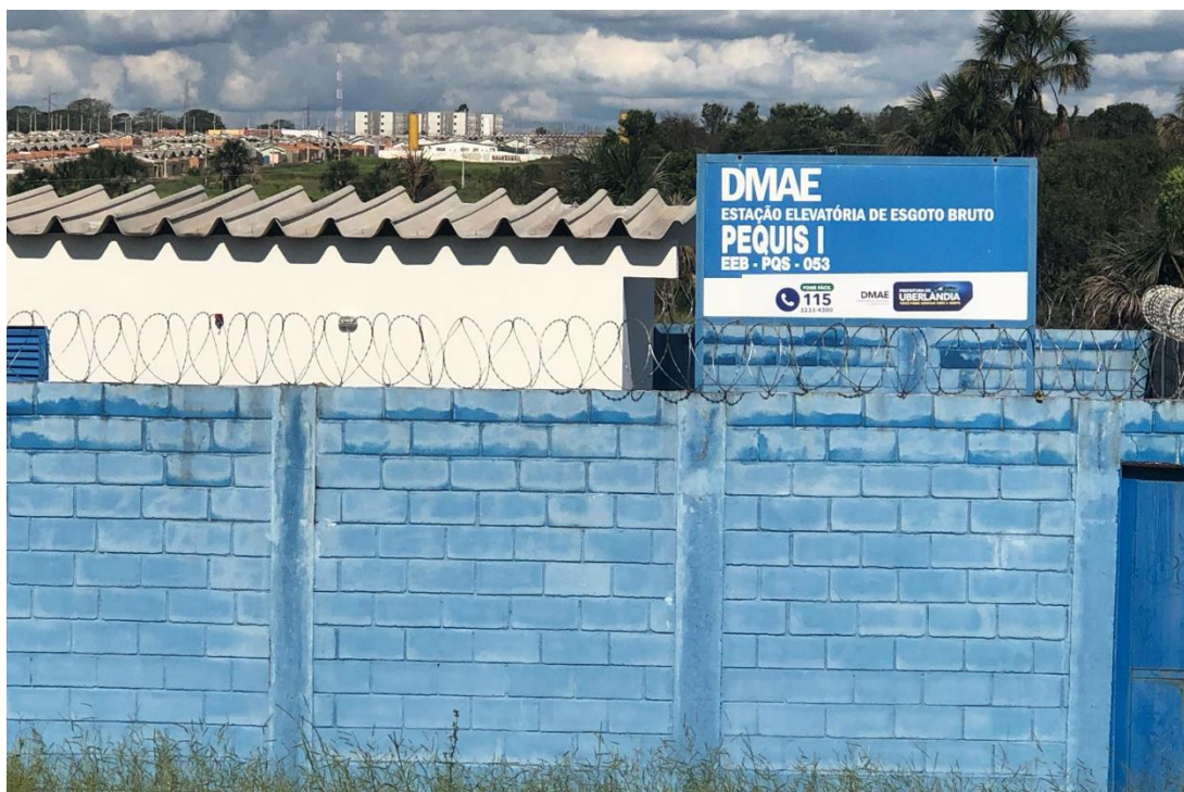
Foto 4: Uberlândia, MG – Estação Elevatória de Esgoto Bruto no Residencial Pequis.
