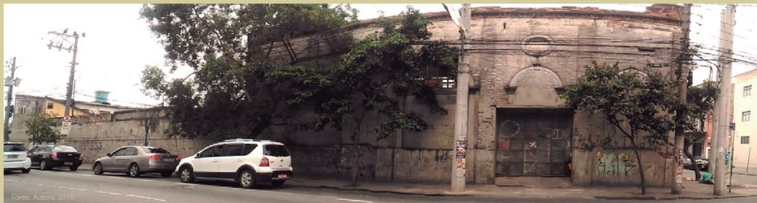
FACHADA PARA RUA JÓAO TEODORO
