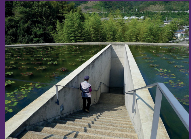
Figura 29: Escada acesso Templo da Água
