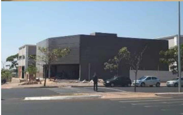
Figuras 61 e 62: Supermercado em fase final de construção no bairro Granja Marileusa
