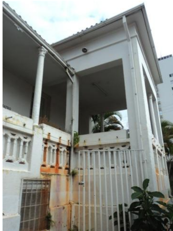
Figura 38 – Alpendre antes de ser demolido, 2014. Fonte: Acervo pessoal do autor.
