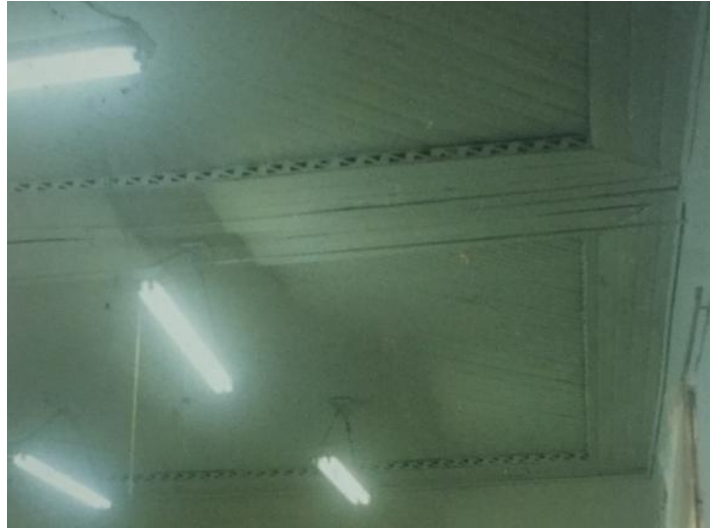
Figura 36 – Interior de uma das salas de aula do Colégio Anchieta, 1999. Detalhe para o forro de madeira ainda conservado e aparente. Fonte: Processo de Tombamento – Imóvel Rua Tiradentes, 77 – Colégio Anchieta. Trabalho acadêmico realizado na disciplina Técnicas Retrospectivas, da Faculdade de Arquitetura e Urbanismo – Universidade Federal de Uberlândia, 1999.
