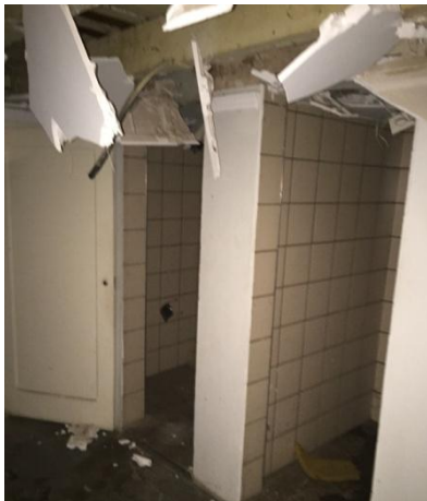
Foto 19. Forro de gesso quebrado próximo aos banheiros do porão. Data: 05/04/2016.
