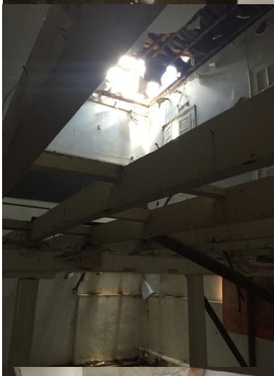
Foto 20: Detalhe para a cobertura do salão nobre destelhada. Data: 22/12/2015.
