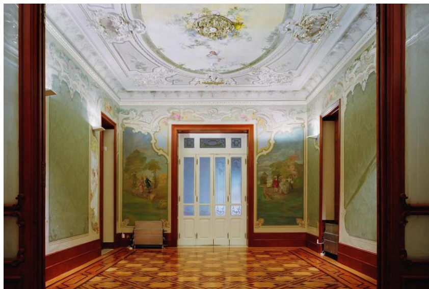
Figura 18 – No interior, o teto com rebuscados afrescos e o piso de marchetaria foram preservados e restaurados. Fonte: http://www.galeriadaarquitectura.com.br/projeto/brasil-arquitetura_/museu-rodin-bahia/2799
