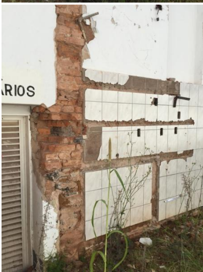
Foto 14. Situação após remoção do alpendre. Data: 22/12/2015.
