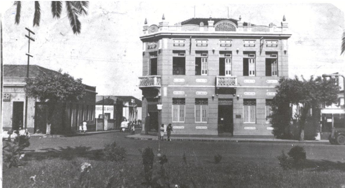
Figura 7 – Companhia de Força e Luz (atual Oficina Cultural), 1929. Fonte: Arquivo Público Municipal de Uberlândia.
