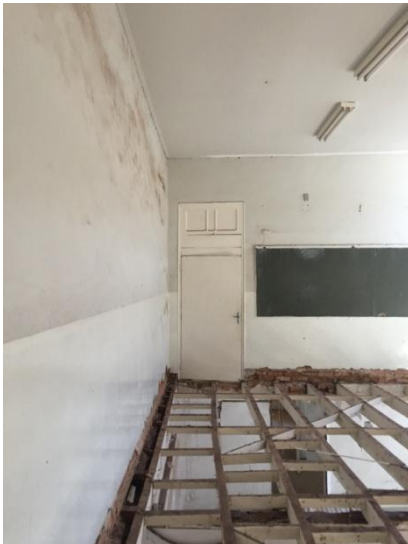
Foto 26. Salão nobre sem o piso. Data: 21/05/2016.
