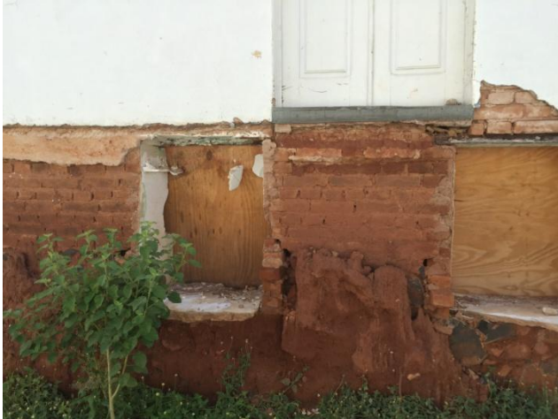
Foto 13. Situação após remoção do alpendre. Data: 22/12/2015.
