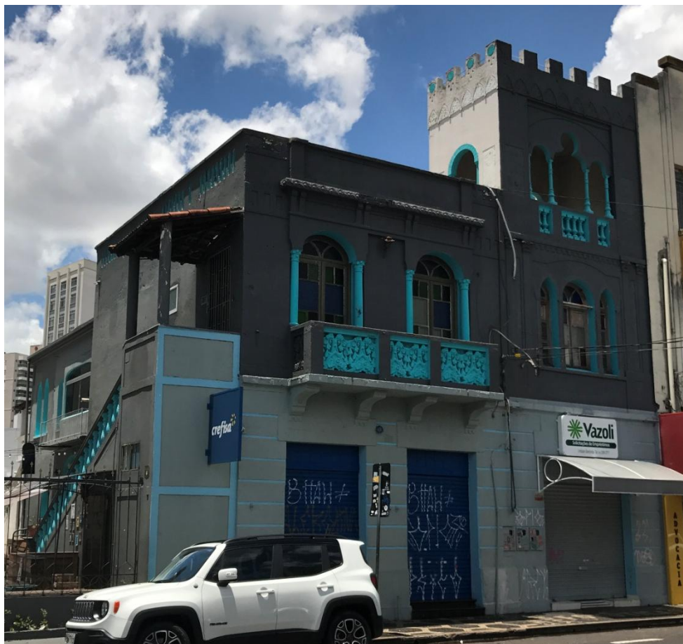
Figura 14 – Edifício Naguetini, 2017. Fonte: Autor.
