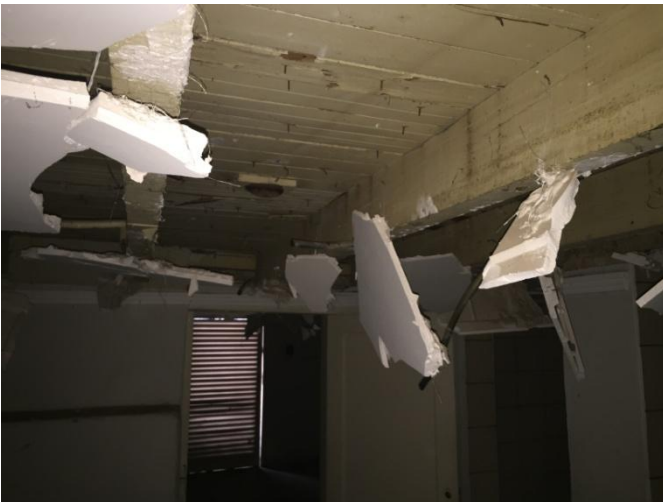
Foto 17. Detalhe do forro de gesso quebrado. Data: 05/04/2016.
