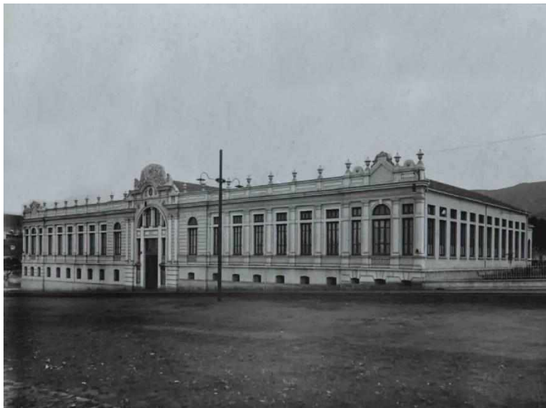
Figura 1. Grupo Escolar Barão do Rio Branco, “Palácio da instrução”, primeiro Grupo Escolar de Belo Horizonte
