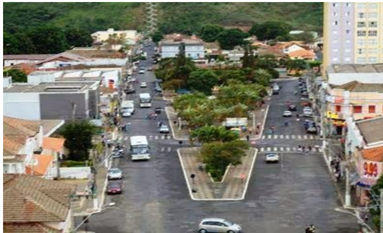
Figura 116: Foto da praça antes da intervenção.
