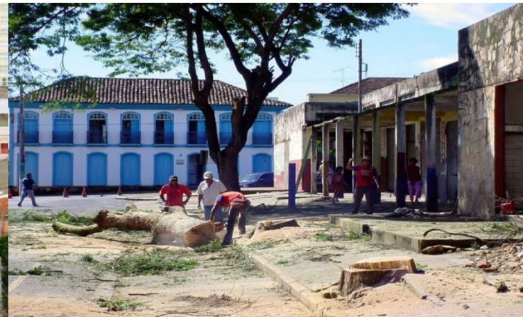
Figura 117: Mercado municipal antes da demolição.
