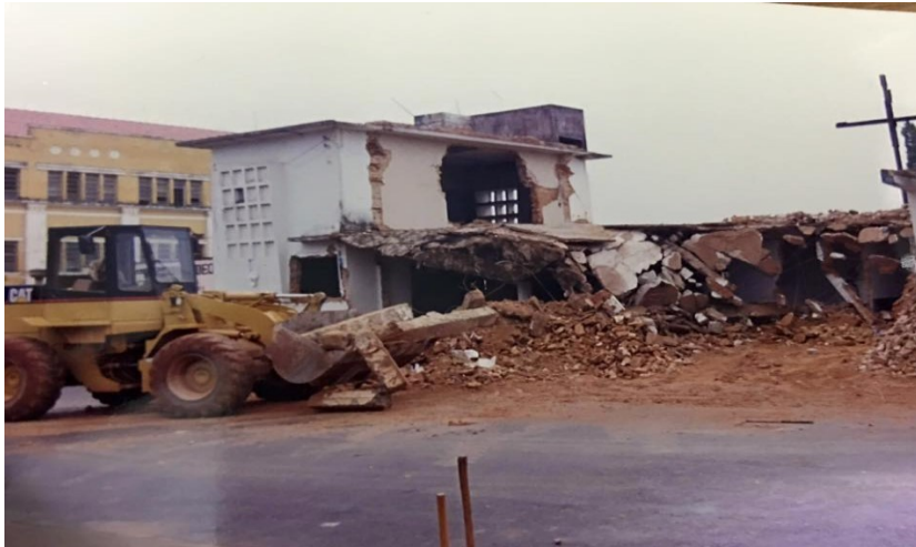
Figura 35: Antiga rodoviária sendo demolida nos anos 90. FONTE: Acervo SEMEC. (2019)
