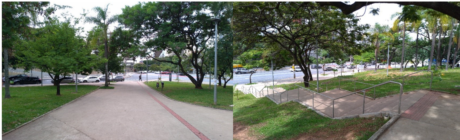
Figura 127 e 128: Acessos rampados e escadas. FONTE: elaborado pelo autor. (2019).
