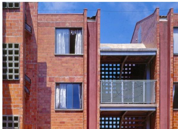
Figura 12. Técnica Construtiva utilizada - Alvenaria de blocos cerâmicos autoportantes e escadas em estrutura metálica independente.
