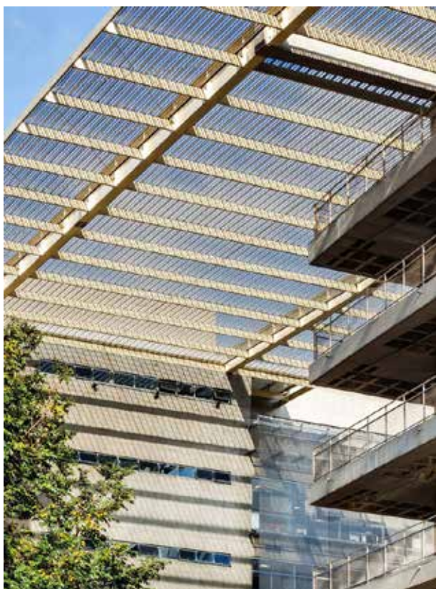
FIGURA 45: Centro Paula Souza - Cobertura metálica
