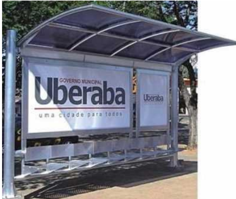
FIGURA 1 – Abrigos de ônibus em Uberaba
