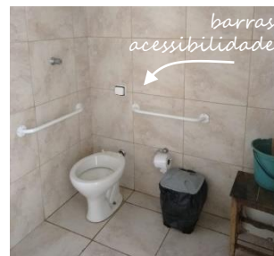
Figura 107: WC acessível. 2019. Fonte: Autora.
