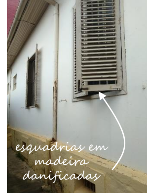
Figura 85: Esquadrias de Madeira. 2019. Fonte: Autora.
