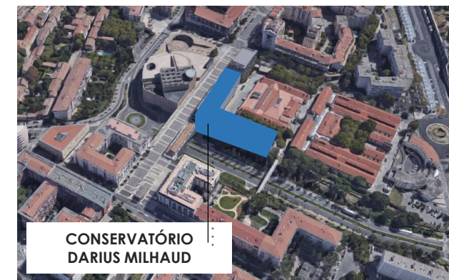
Figura 152: Vista Aérea Conservatório Darius Milhaud. 2019. Fonte: Google Earth Maps
