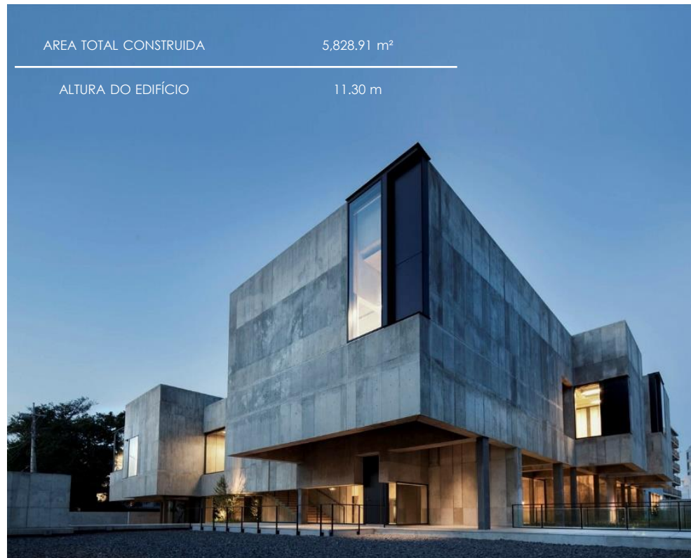
Figura 128: Fachada Principal Escola de Música Toho Gakuen. Tóquio. 2016. Fonte: Nikken Sekkei Architecture.
