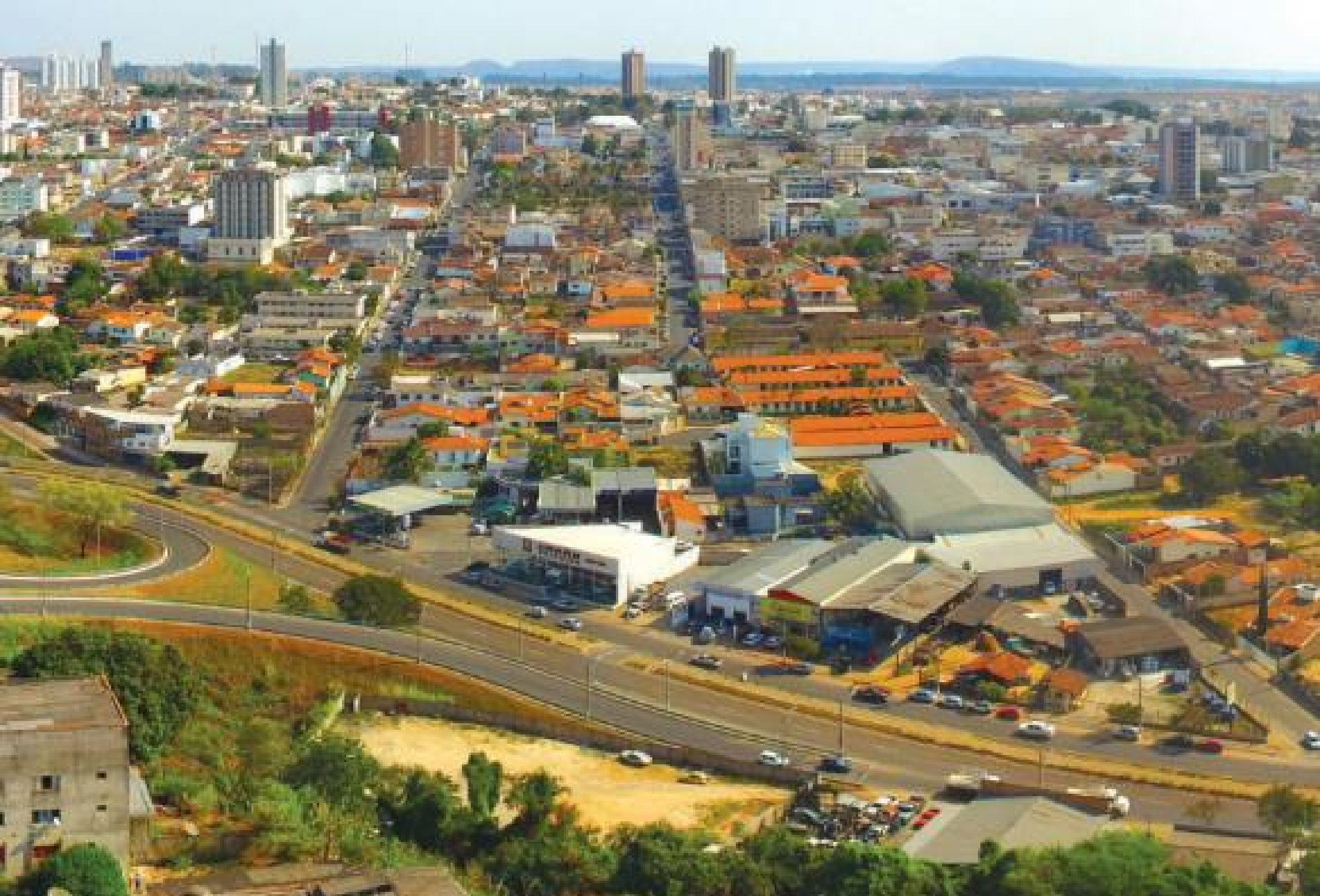
Figura 16: Vista Aérea da cidade; rotatória de acesso à BR262. Araxá-MG. 2016. Fonte: Arquivo SAPP/FCCB
