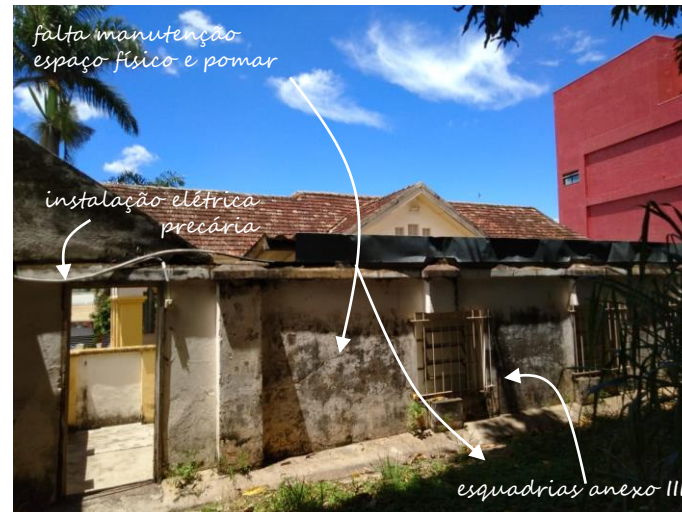
Figura 113: Vista Anexo IV para Anexo II. 2019. Fonte: Autora.
