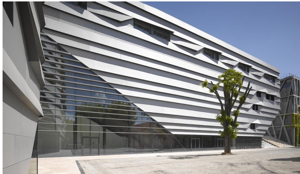
Figura 156: Pátio Interno _ Conservatório Darius Milhaud. França. 2014. Fonte: ArchDaily.
