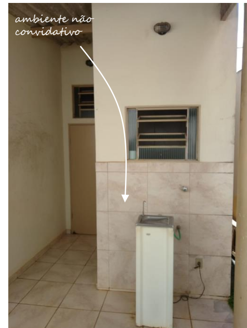
Figura 108: Hall Banheiros - Anexo III. 2019. Fonte: Autora.
