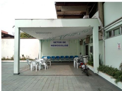
Acesso de pedestres
