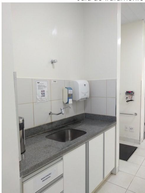
Lavatório de fistulas
