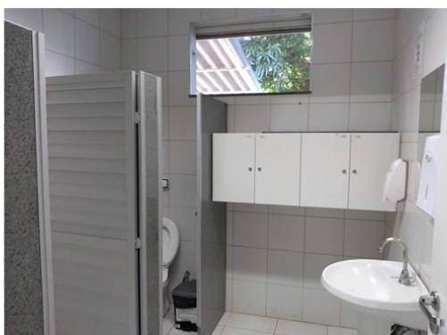
Vestiário de funcionários
