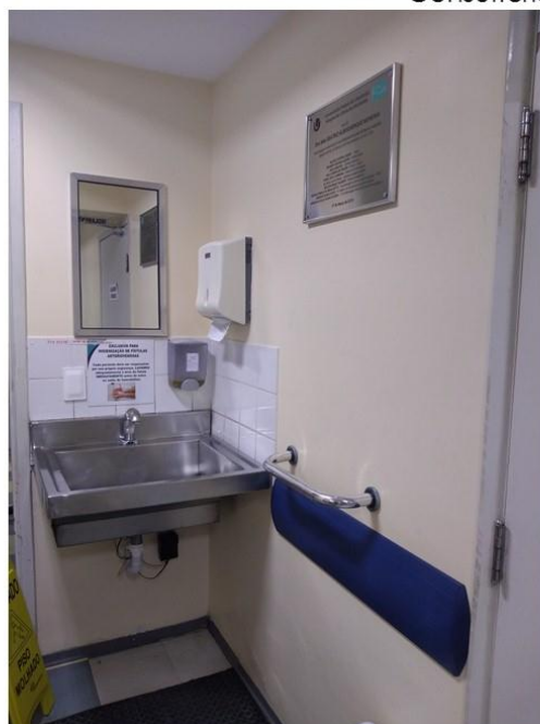
Lavatório de fistulas
