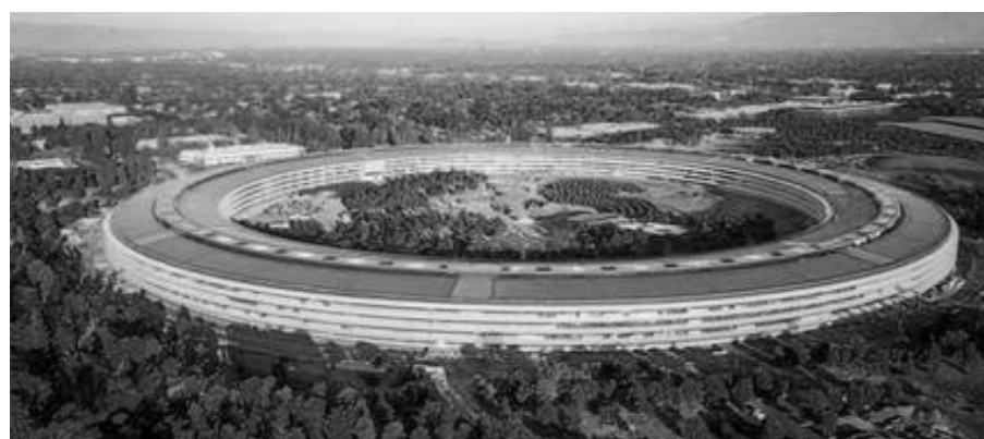
FIGURA 16 - O FORMATO CIRCULAR DO NOVO PRÉDIO DA SEDE DA APPLE FONTE: DIVULGAÇÃO APPLE DISPONÍVEL EM: <HTTP://WWW.SPIEGEL.DE/INTERNATIONAL/WORLD/TECH-GIANTS-LIKE-APPLE-AND-AMAZON-BUILDING-MONUMENTS-TO-DIGITAL-DOMINATION-A-936095.HTML>
