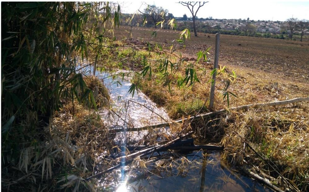
Figura 15: Canal artificial barrado por queda de vegetação Fonte: Autor
