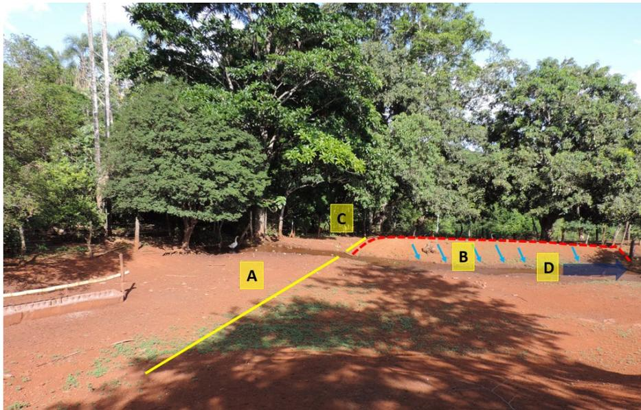
Figura 11- Descontinuidade do dique por corte de estrada. Fonte: elaborado pelo autor
