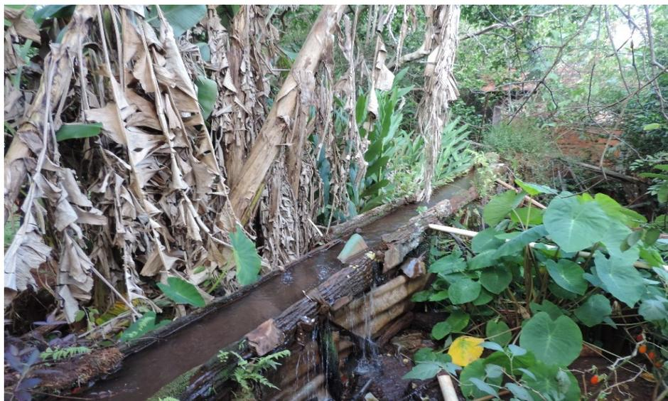
Figura 13- Canal produzido por meio de tronco entalhado para produzir desnível em relação ao solo. Fonte: Autor
