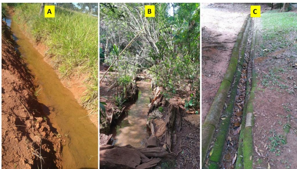
Figura 10- Exemplos de diques. (A) Dique confeccionado pelo material da vertente (solo) (B) Dique confeccionado por solo e madeira (C) Dique de concreto Fonte: elaborado pelo autor
