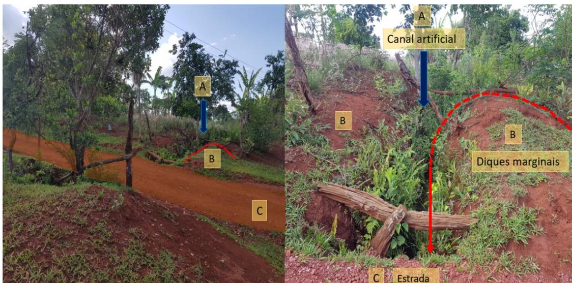
Figura 9- Corte profundo no solo para estabelecimento do canal artificial. Fonte: elaborado pelo autor
