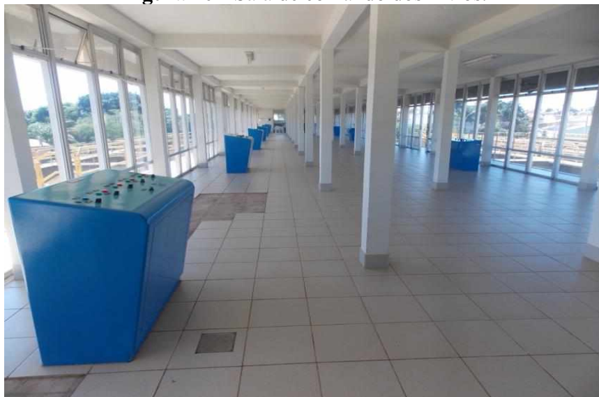
Figura 10 – Sala de comando dos filtros.
