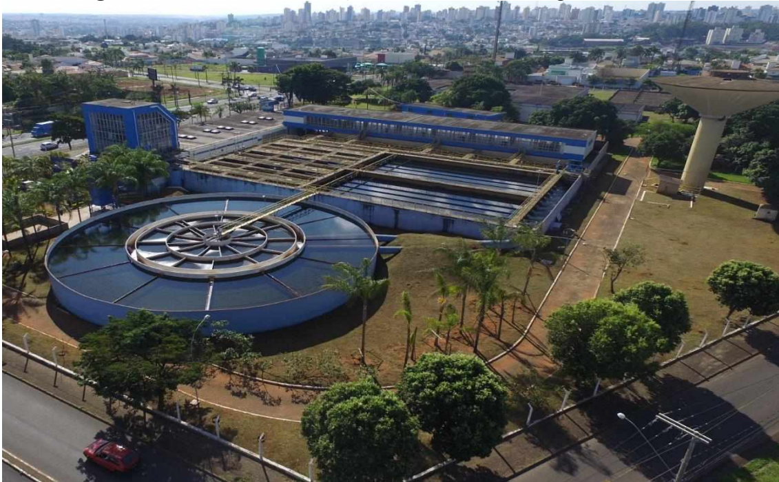
Figura 5 – Vista aérea da Estação de Tratamento de Água Bom Jardim.
