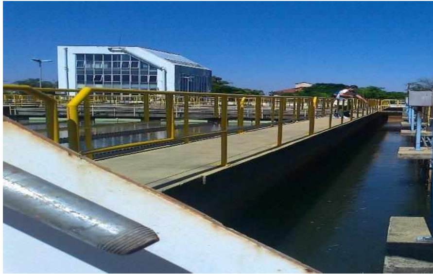
Figura 6 – Vista do canal de água decantada.
