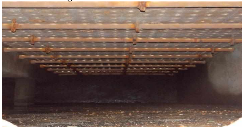
Figura 8 – Fundo falso dos filtros.
