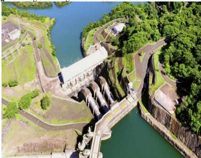
Figura 2 Registro fotográfico da Usina Hidrelétrica de Miranda.
