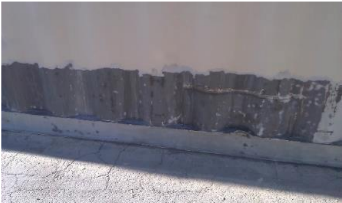
Figura 28: Limpeza através de hidrojateamento Fonte: BRSETE (2016)
