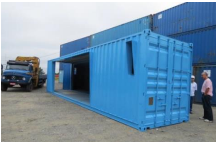
Figura 24: Container já cortado na preparação para uso em construção civil Fonte: BRSETE (2016)
