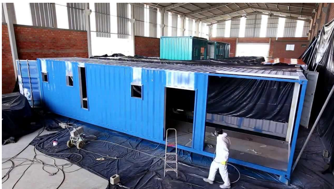
Figura 29: Pintura de acabamento Fonte: BRSETE (2016)
