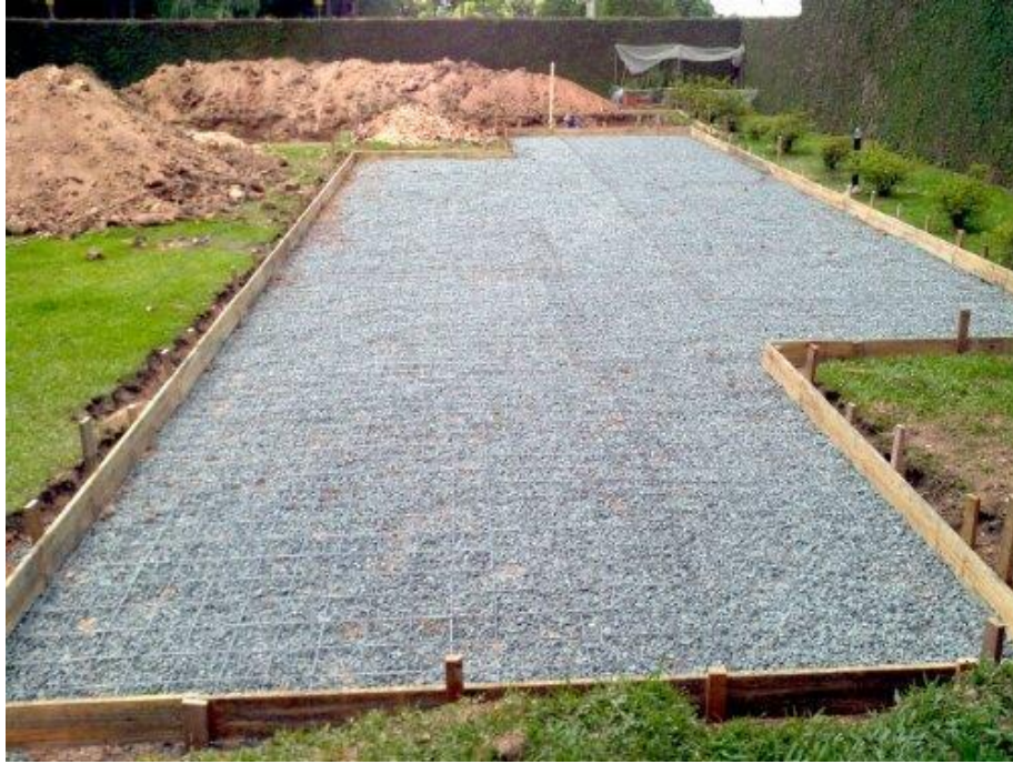
Figura 33: Fundação tipo radier Fonte: MINHA CASA CONTAINER (2016)
