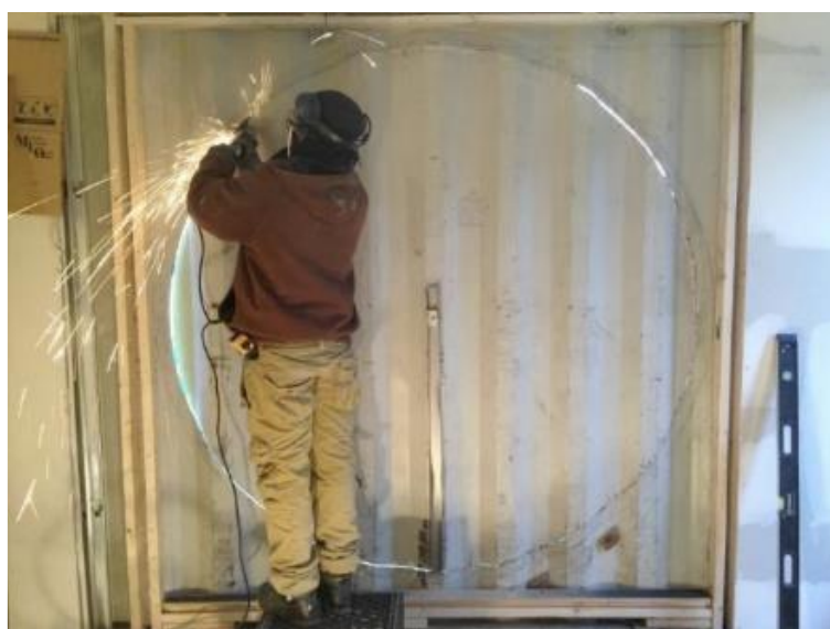
Figura 25: Abertura de área para esquadria Fonte: BRSETE (2016)
