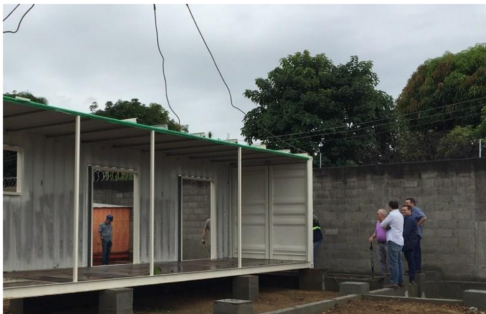
Figura 34: Container apoiado em fundação tipo sapata isolada Fonte: MINHA CASA CONTAINER (2016)
