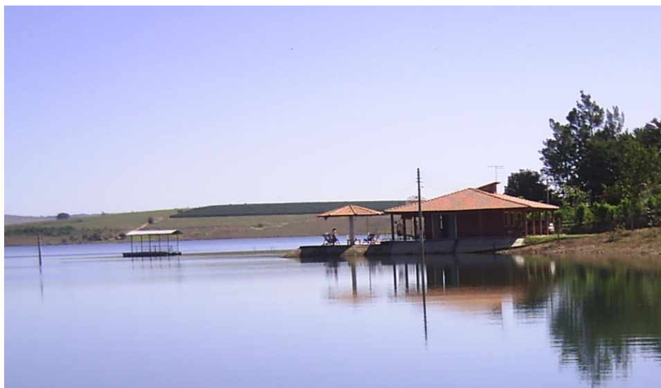
Figura 18: Casa com nível de água avançado Fonte: Autor (2010)
