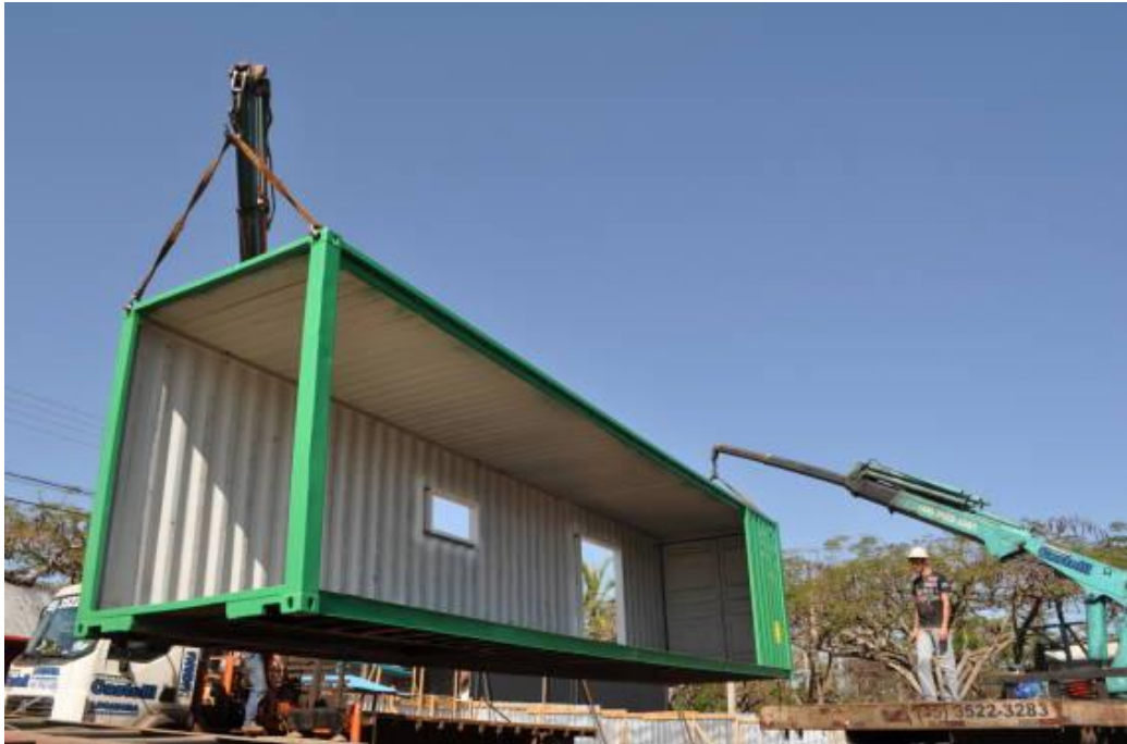
Figura 22: Caminhão Munck posicionando contêiner Fonte: Casa e construção (2019)
