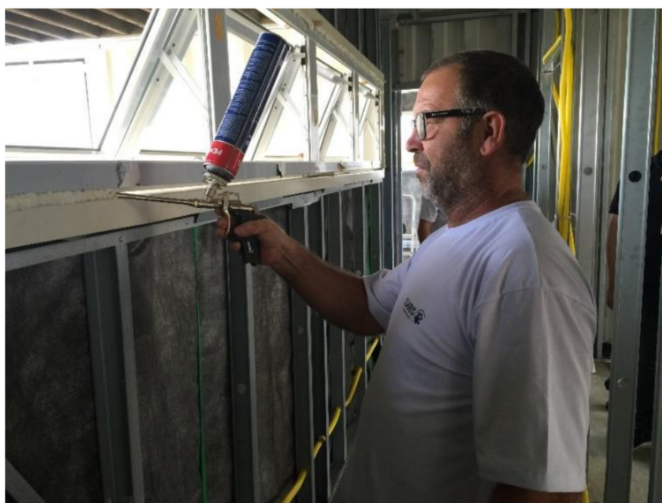
Figura 26: Janela instalada e com a aplicação da espuma expansiva Fonte: BRSETE (2016)
