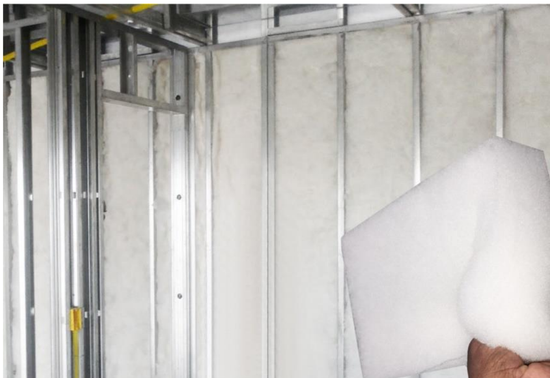
Figura 43: Lã de PET usado no isolamento térmico dos contêineres Fonte: Miranda Container (2019)
