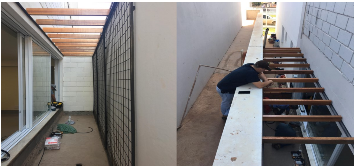
FIGURA 10 – Colocação da treliça no local definitivo do projeto e de percolado
