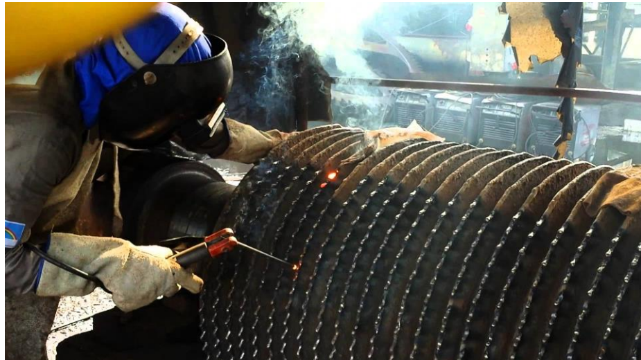
Figura 15-Manutenção de moenda com eletrodo revestido
